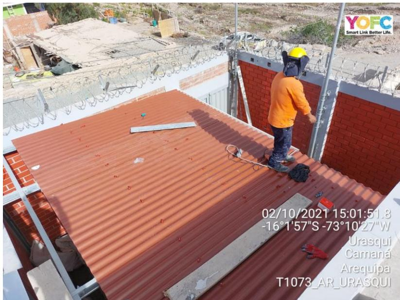
**Figura 21.** Riesgo de caída por no usar equipo anticaída.
