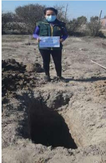
**Figura 10.** Excavación de calicata para estudios previos en laboratorio
