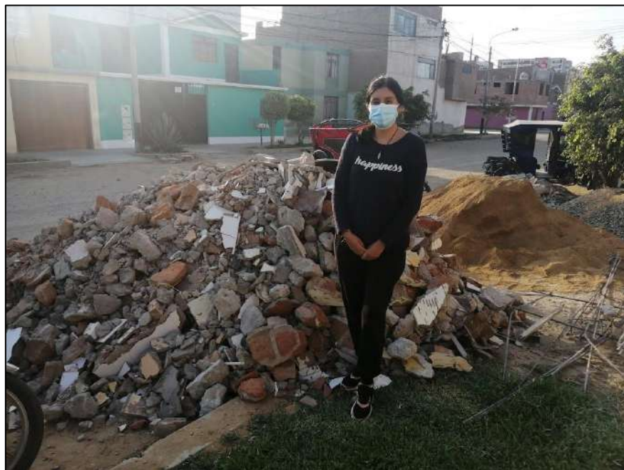
Figura 20. Material de concreto reciclado de demolición proveniente de columnas. Fuente: propia.
