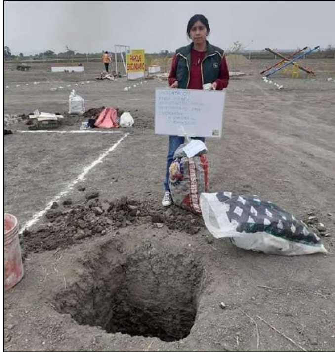
Figura 5. Ejecución de calicatas en Lotización Santa Fe. Fuente: propia.
