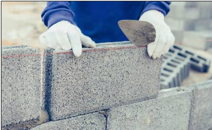
*Figura 3. Bloque de concreto ligero (concreto celular). Fuente: (Archdaily, 2020)*
