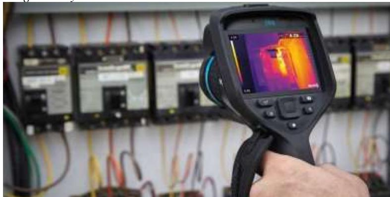
Según la ley de ohm,  $P=I^2 \times R$ ., Una vez que se tiene un punto con la resistencia, el calor generado se transfiere a la armadura y al aire. Una imagen (termograma) de este momento dará una zona caliente en la conexión y la temperatura decreciente es la distancia de las conexiones ascendentes.
