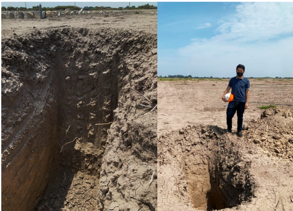
Figura 87. Calicata excavada en el distrito de Monsefú – Lotización Galilea.
