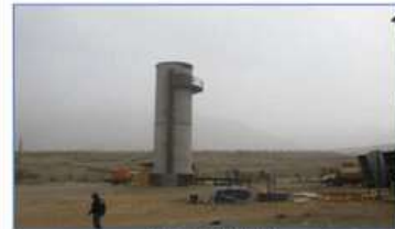
Quemador de Biogás
