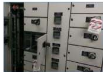
Instalación de Tablero Eléctrico
