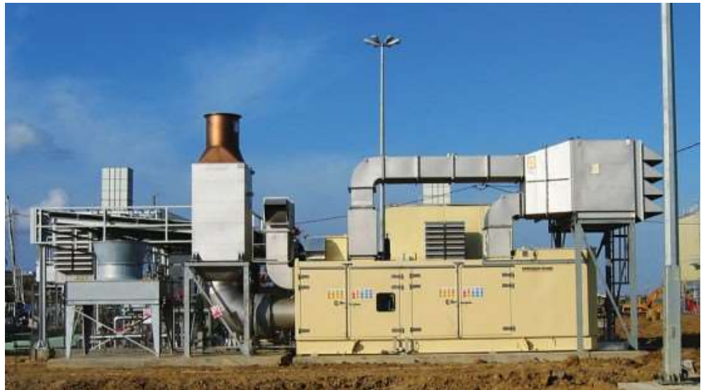
Figura 13: Turbina de gas KG2
