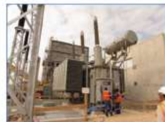
Transformador de potencia en proceso de montaje
