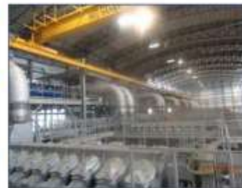
Vista de Montaje de Tubos de Escape
