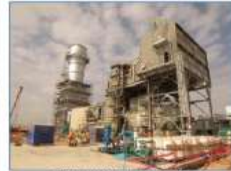
Turbogenerador, montaje mecánico
