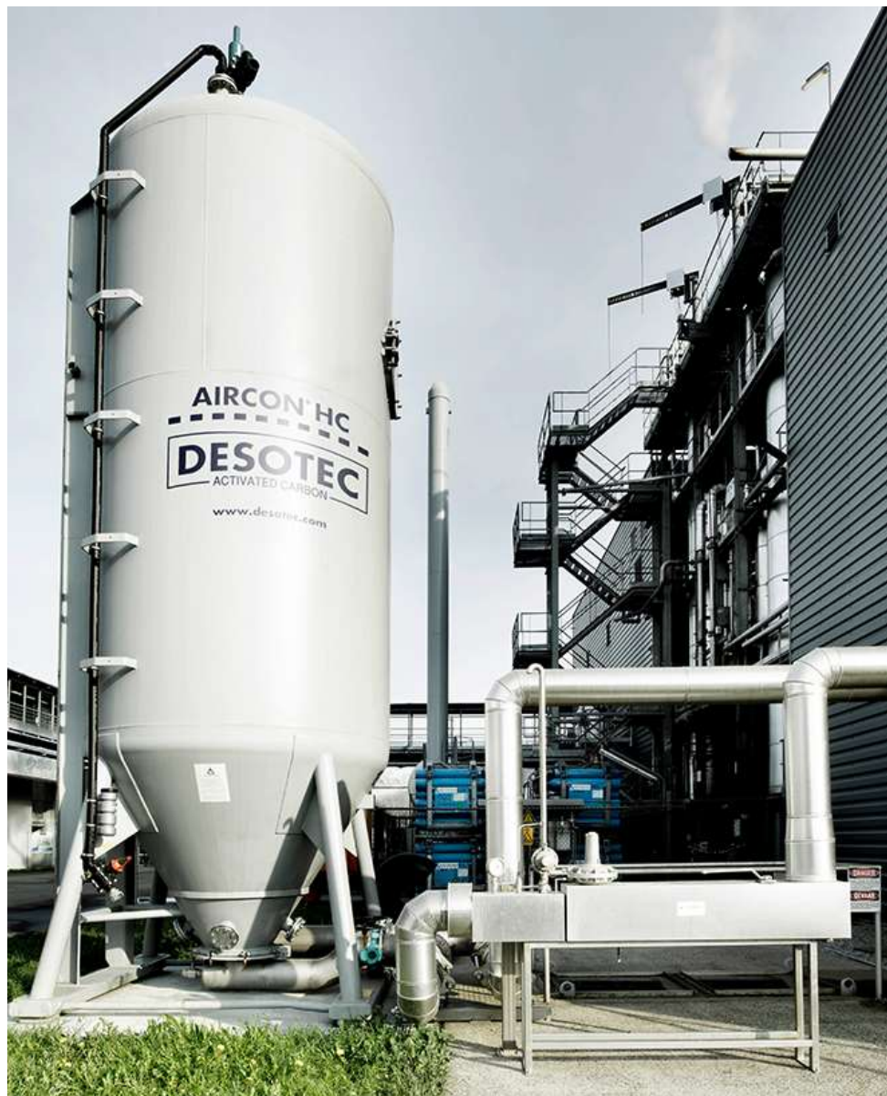
Figura 12: Filtro de biogás Desotec Aircon HD
