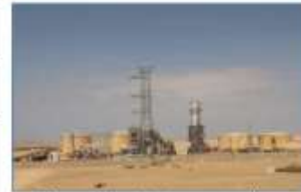
Vista panorámica de las obras en construcción
