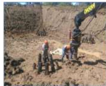
Instalación de pilotes en tramo aéreo de la línea
