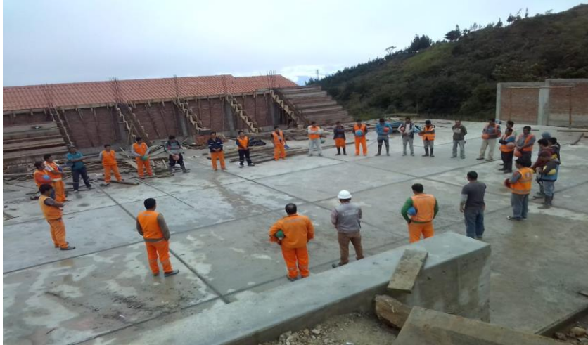
Imagen de la ejecución de obras por parte la empresa 2B & C Ingenieros S.A.C Encuesta aplicada a los trabajadores
