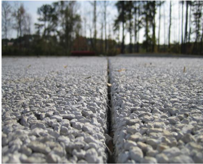
Figura 1: Vista de pavimento de concreto permeable. Fuente: (ARGOS, 2020)
