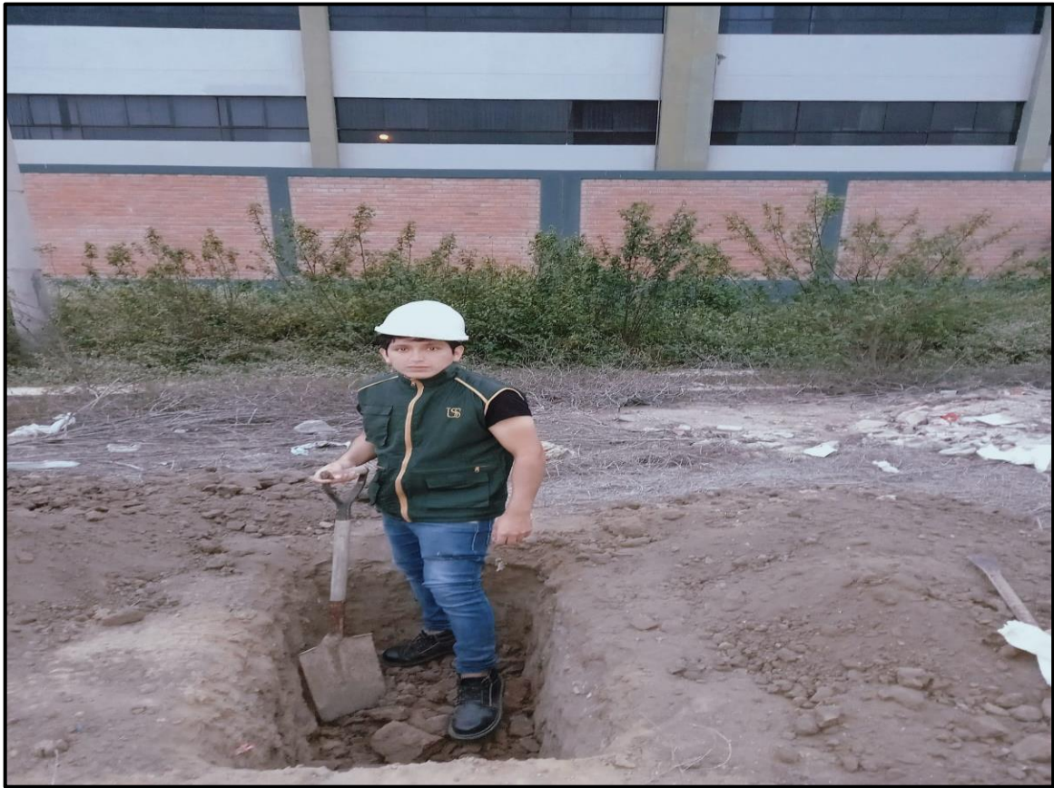
Figura 96: Excavación de calicata en los Sauces – Pimentel
