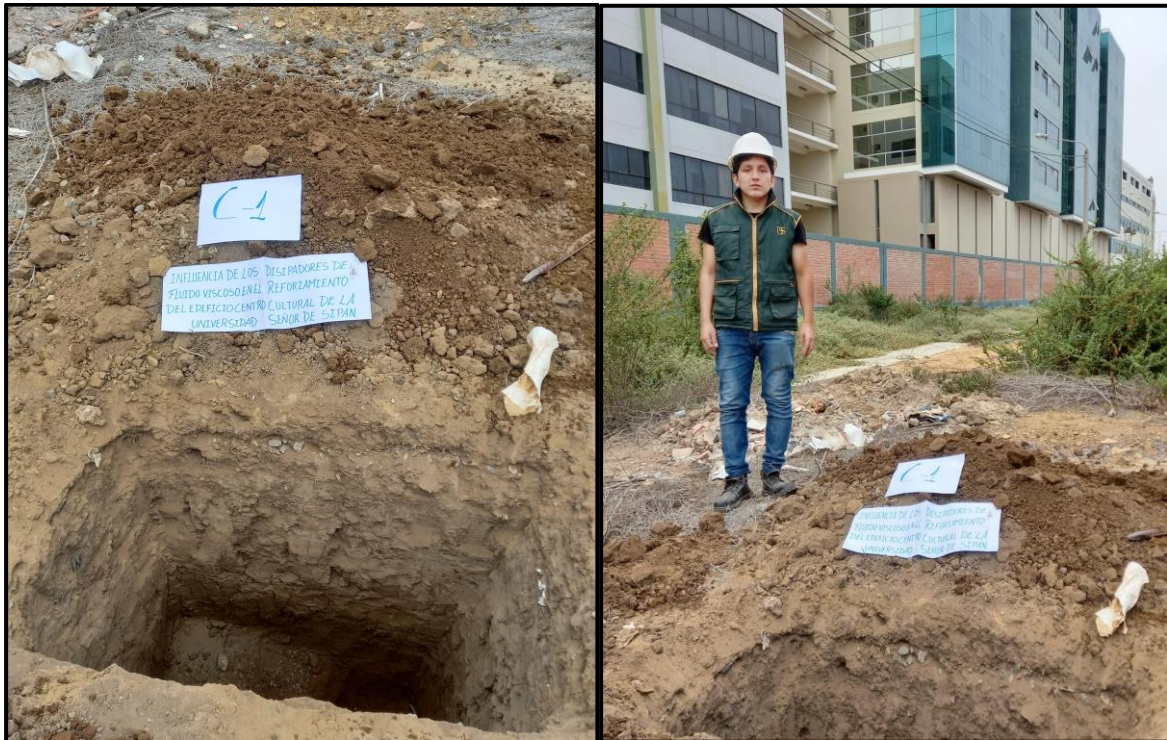
Figura 97: Trabajo de excavación culminado
