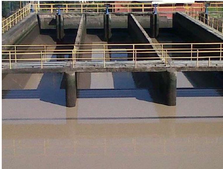
FOTO: N°6. DESCRIPCION: BOCATOMA-RACARUMI.
