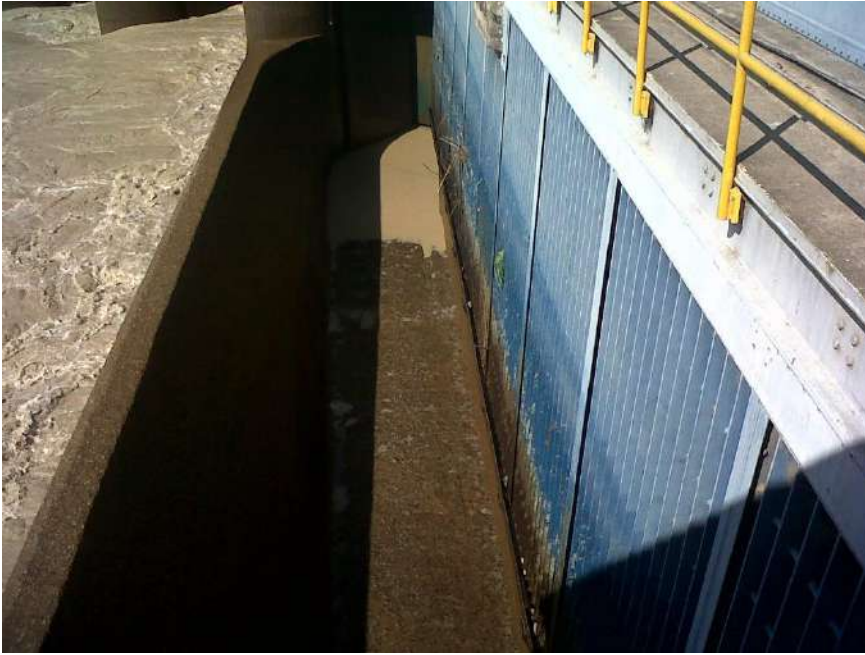
FOTO: N°9. DESCRIPCION: BOCATOMA-RACARUMI.
