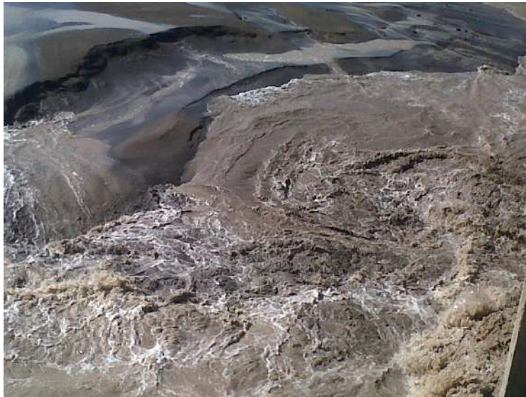
FOTO: N°. DESCRIPCION: BOCATOMA-RACARUMI.
