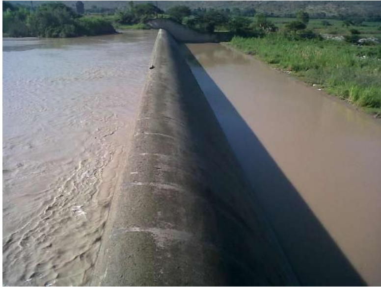
FOTO: N°7. DESCRIPCION: BOCATOMA-RACARUMI.
