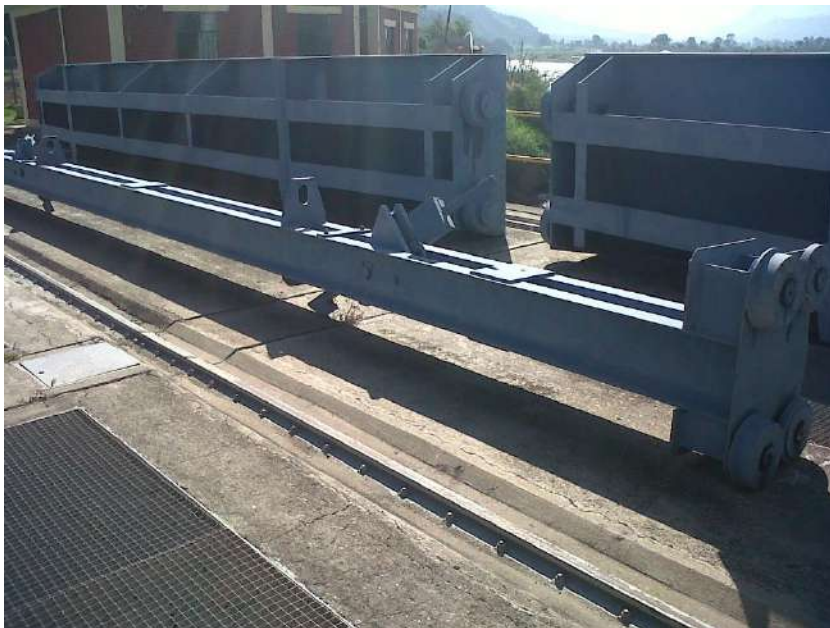
FOTO: N°10. DESCRIPCION: BOCATOMA-RACARUMI.
