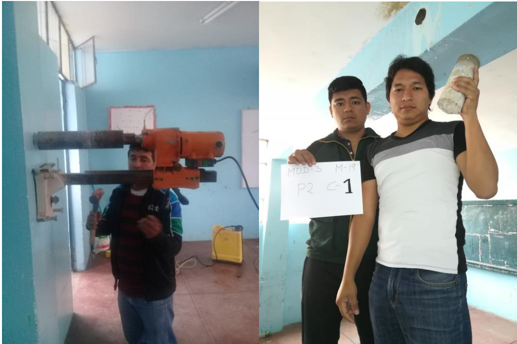
Figura 19: Extracción con el taladro diamantino. Fuente: Elaboración propia.
