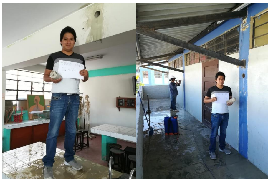
Figura 20: Extracción de núcleo de concreto – Diamantina. Fuente: Elaboración propia.
