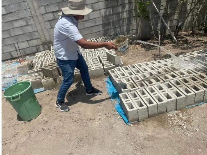
**Figura 4.** Bloque de concreto tipo P elaborada in situ.
