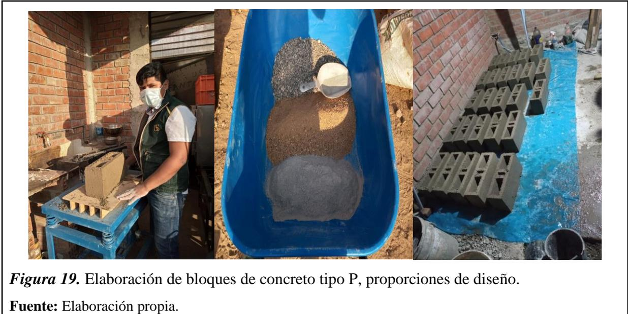
**Figura 19.** Elaboración de bloques de concreto tipo P, proporciones de diseño.
