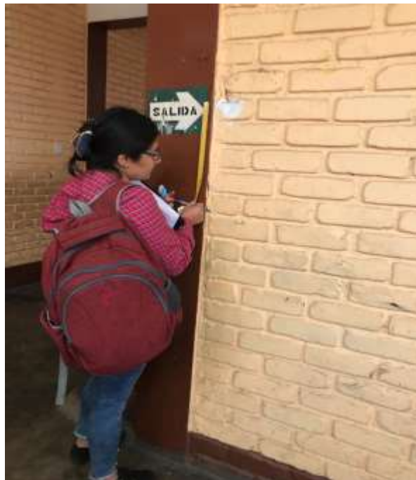
Figura 32: Inspección de patologías en las estructuras
