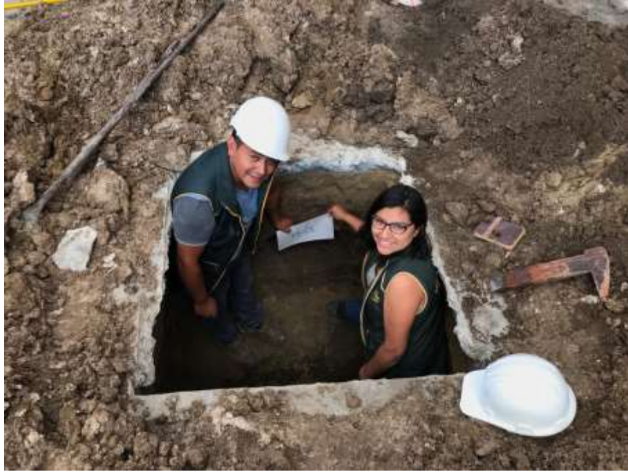
Figura 33: Realización de calicata en la I.E N°10828
