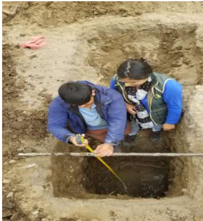
Figura 34: Realización de calicata en la I.E N°11017
