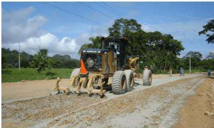
**Figura 21:** Estabilización con cemento portland.
