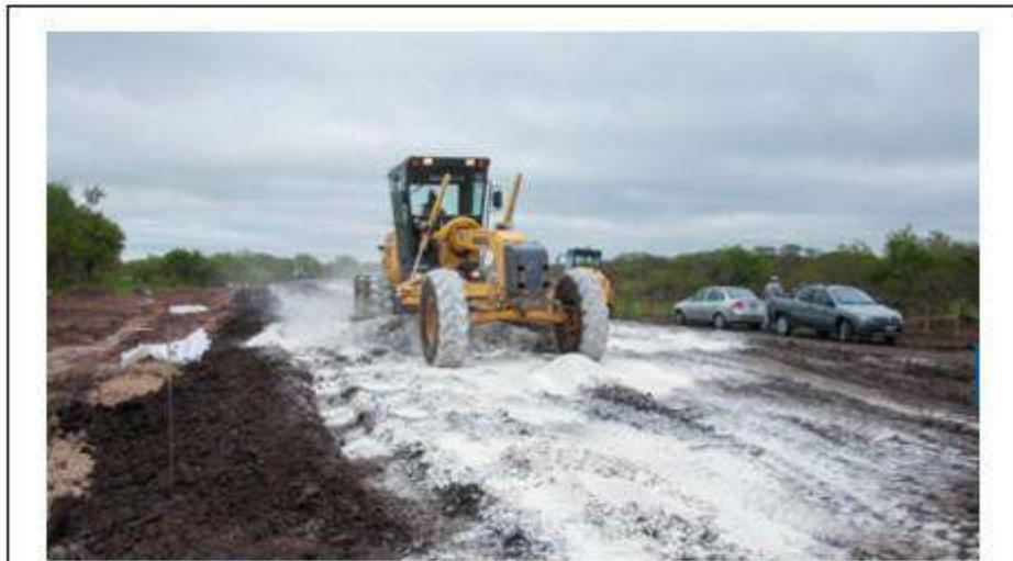
**Figura 23:** Mezclado de suelo con cal.
