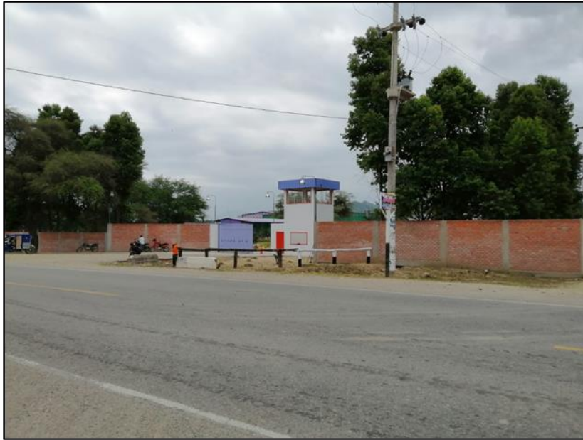
Figura 5. Vista de acceso a instalaciones productivas de la empresa QUICORNAC SAC.
