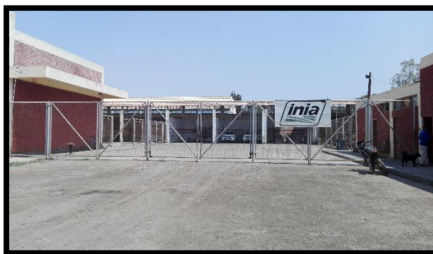
Figura 4: Entrada de almacén de bienes y materiales
