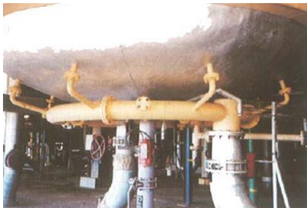
Figura 25: Anillo externo de alimentación para evaporadores.
