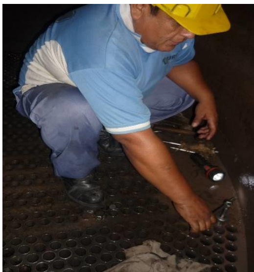
Figura 11: Técnico cambiando un tubo de la calandria dañada.
