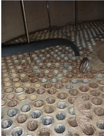
Figura 12: Limpieza mecánica de tubos con rasquetes.
