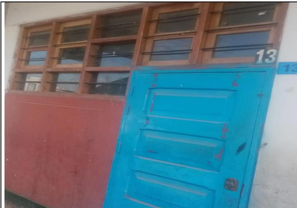
**Figura 20:** Puertas y ventanas en mal estado.
