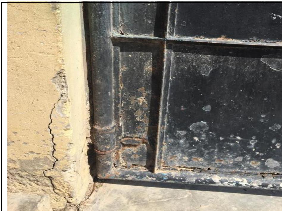
**Figura 23:** Fisuramiento.
