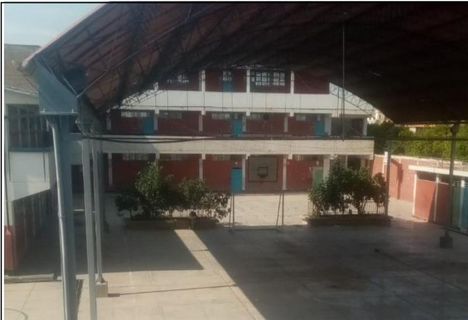
**Figura 22:** Carencia de rigidez lateral en las direcciones al pórtico
