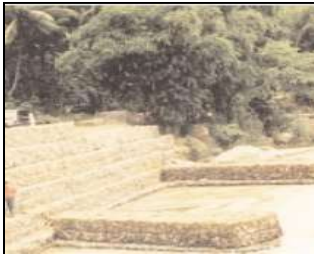
Figura n° 14: Obra deflectora (Espigón).
