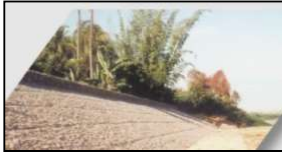
Figura n° 13: Obra longitudinal (Estructura delgada).
