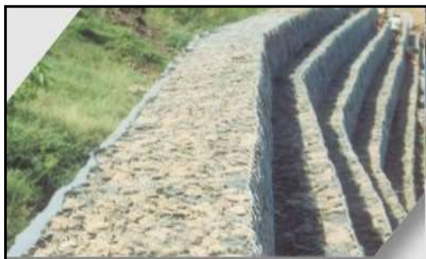
Figura n° 12: Obra longitudinal (Estructura gruesa).
