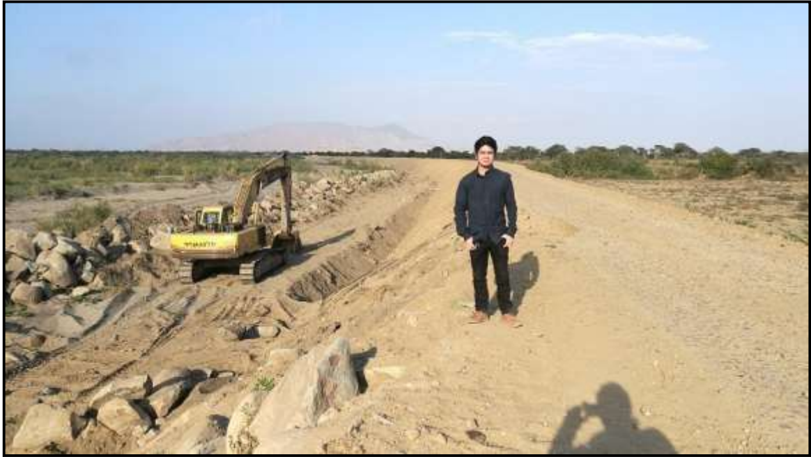
Figura n° 3: Trabajos de reparación de la defensa con enrocado, margen izquierdo, aguas arriba del puente Eten-Monsefú, año 2018.
