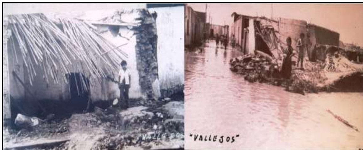
Figura n° 1: Desastres ocasionados por el desborde del río Chancay, Eten.
