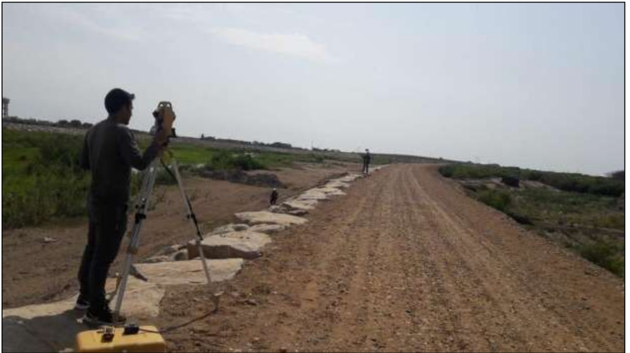
Figura n° 27: Vista panorámica de trabajo topográfico en dique norte.
