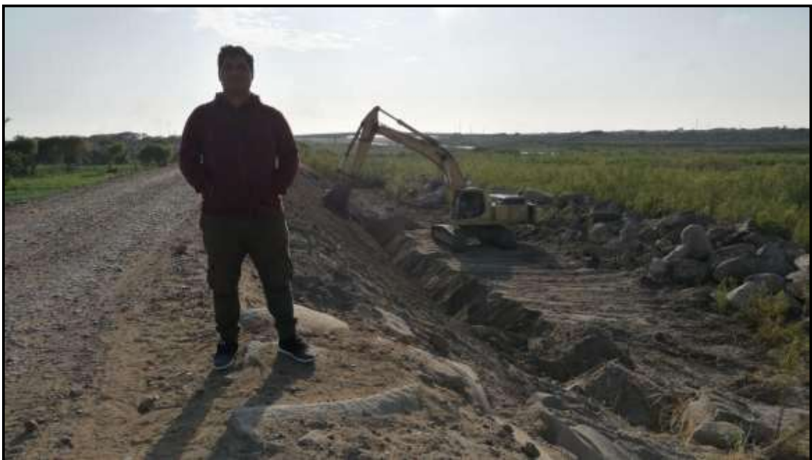
Figura n° 4: Trabajos de reparación de la defensa con enrocado, año 2018, aguas arriba del puente Eten-Monsefú, después del fenómeno del niño del 2017.
