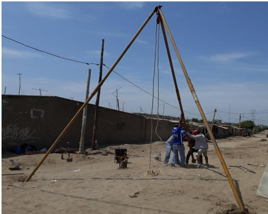
*Figura 63: Ensamblaje del trípode*
