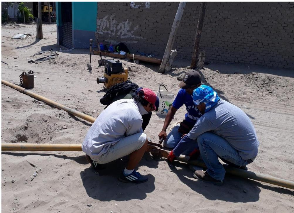
*Figura 61: Inserción del perno de anclaje*
