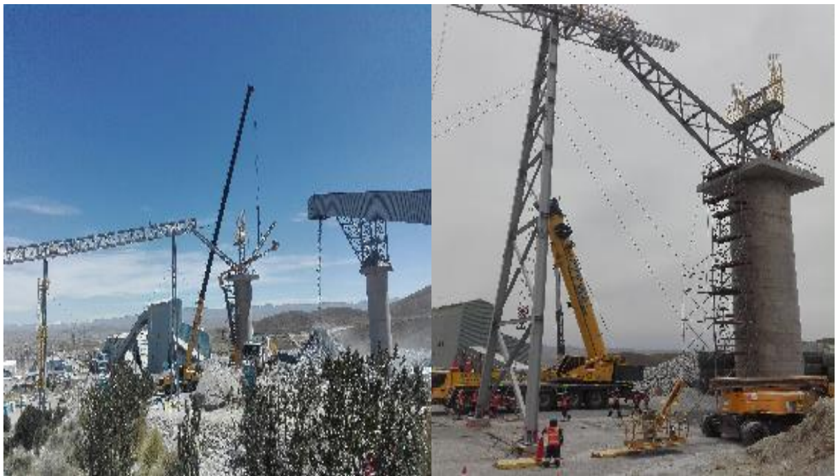
Figura 29. Montaje del Stacker (Apilador).
