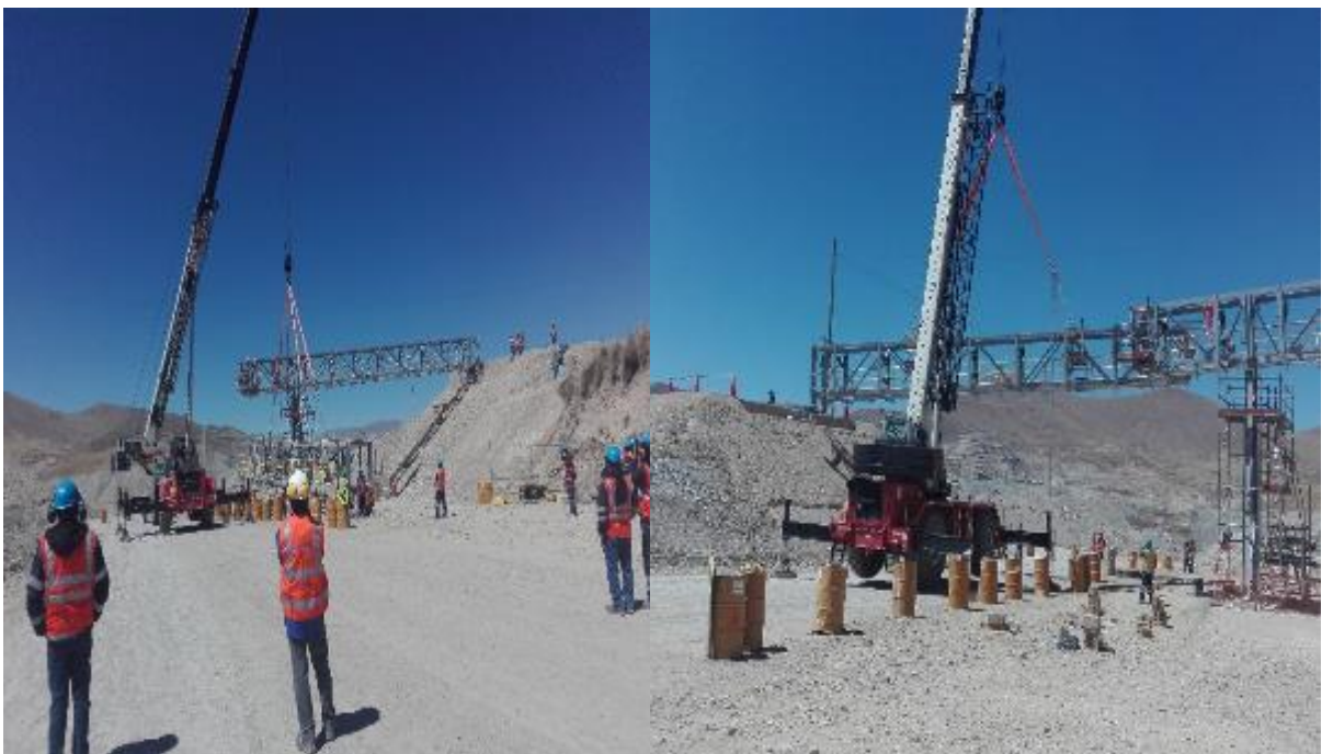
Figura 27. Montaje Puente N°02
