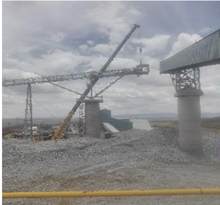
Figura 30. Montaje del Stacker (Apilador).
