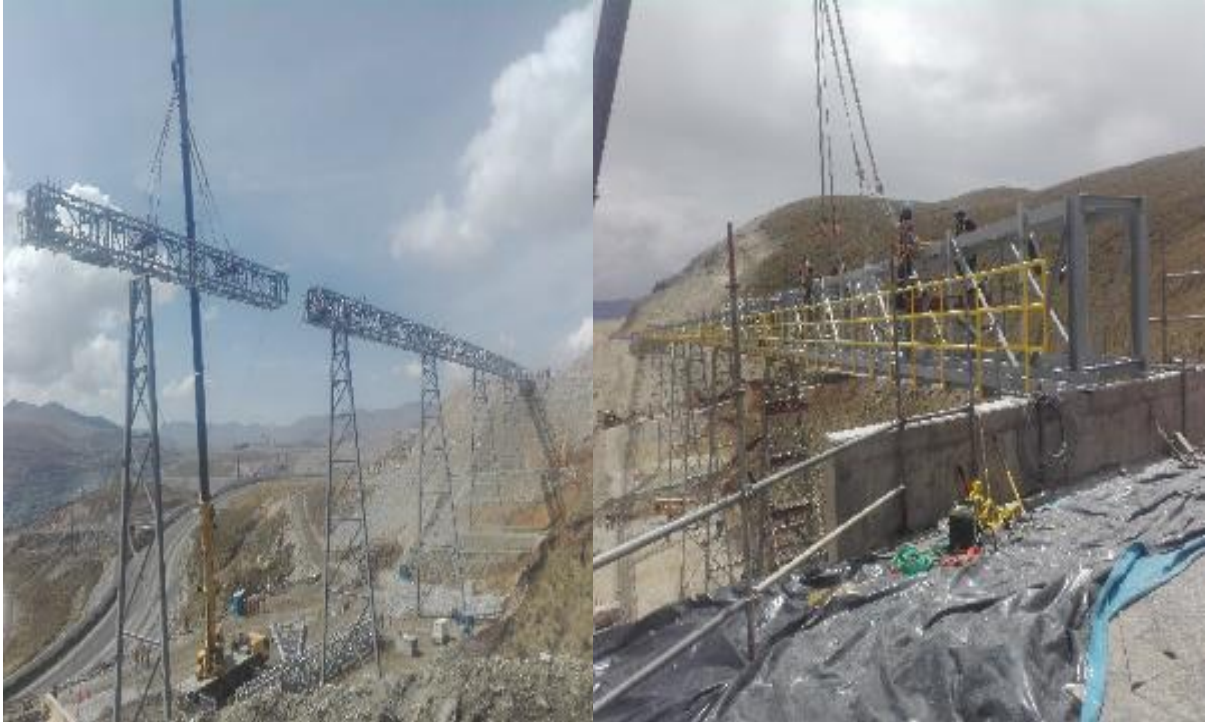
Figura 26. Montaje Puente N° 01
