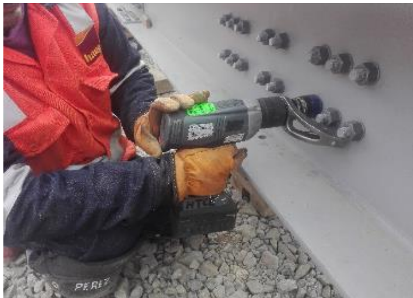
Figura 31. Torque de pernos.
