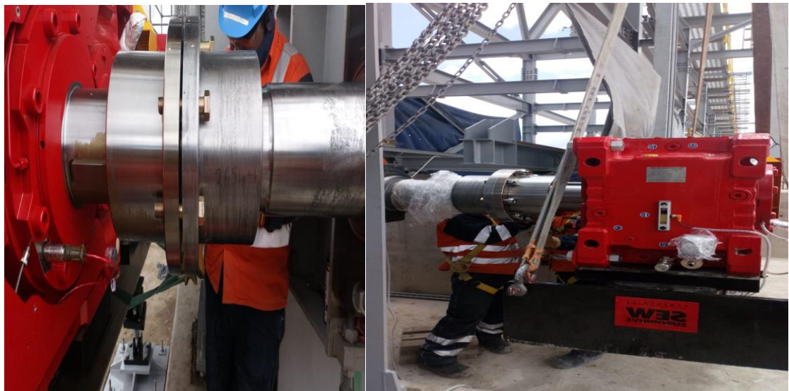
Figura 48. Instalación de polea motriz con Motorreductor
