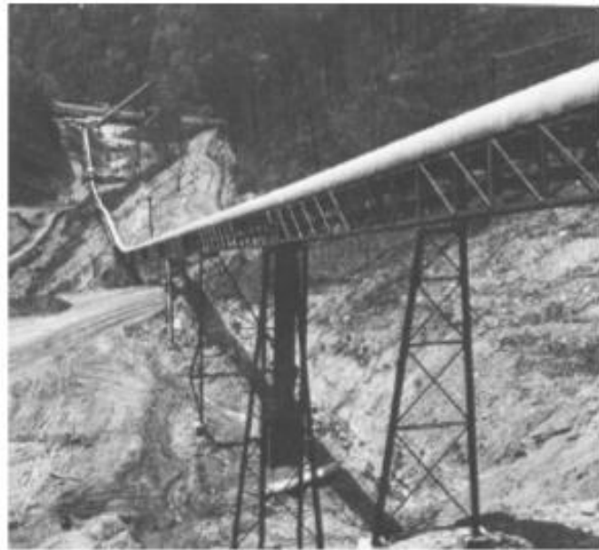
Figura 6. Transportador regenerativo bajando carbón desde una mina hasta la planta de preparación.
