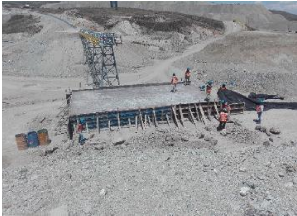
Figura 28. Montaje Puente N° 03.
