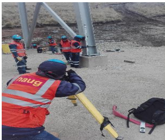
Figura 33. Verificación Topográfica Bents.
