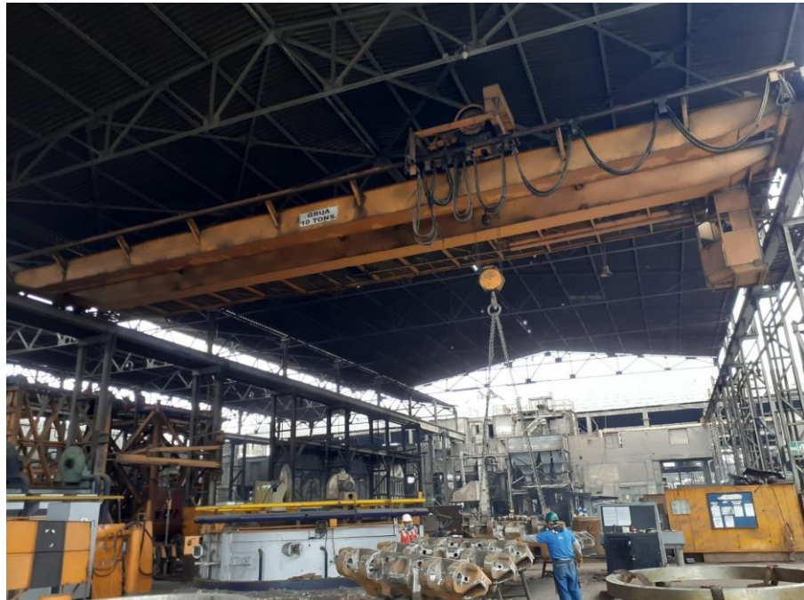
Trabajos de cargas con grúa puente
