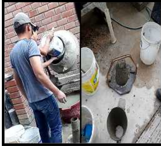
Figura 9.- Preparación del concreto patrón y verificación de la consistencia.
