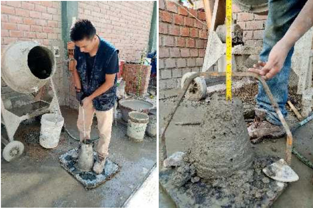
Foto 3: Verificación de la consistencia del concreto
