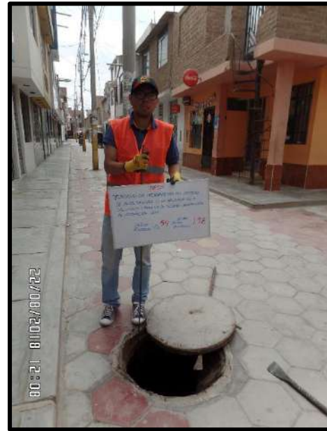
Figura 96. Se puede apreciar otra toma de la realización de mediciones de altura en el buzón ubicado en la Ca. Ramon Herrera y Psj. Domingo Elias.
