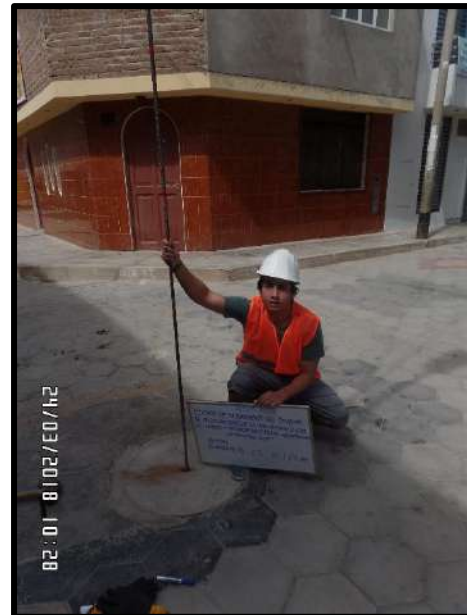
Figura 88. Se puede apreciar otra toma de la realización de mediciones de altura en el buzón ubicado en el Psj. El Sol y Psj, Oasis.
