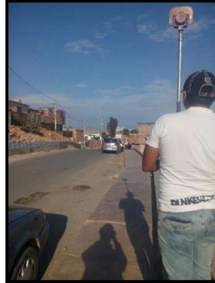
Figura 29. Se puede apreciar que al portamiras esperando la toma de lectura de la estacion total.
