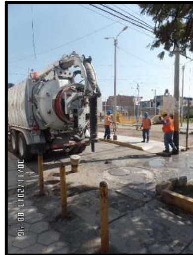
Figura 60. Se puede apreciar otra vista en el calle Ramon Herrera de como es la cantidad de semientos trae desde Diaz Calderon.
