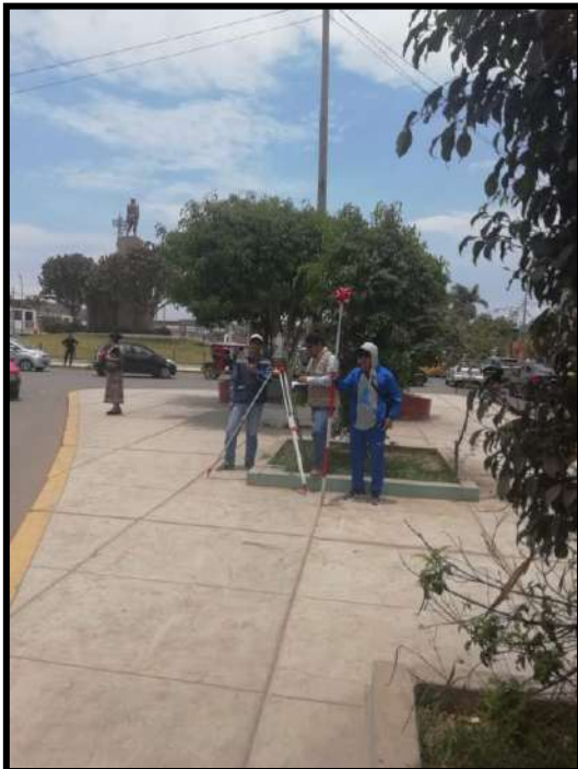
Figura 19. Se comenzo a realizar el trasado del punto geodesico a travez de la estación total.
