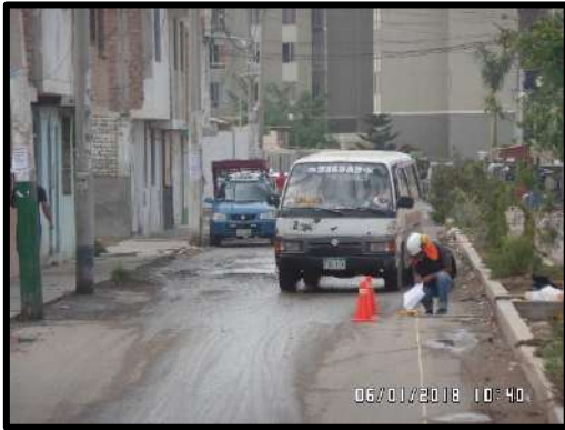
Figura 66. Se puede apreciar otra toma de la realización de mediciones a distancia con wincha en el buzón ubicado en la Av. El Progreso.
