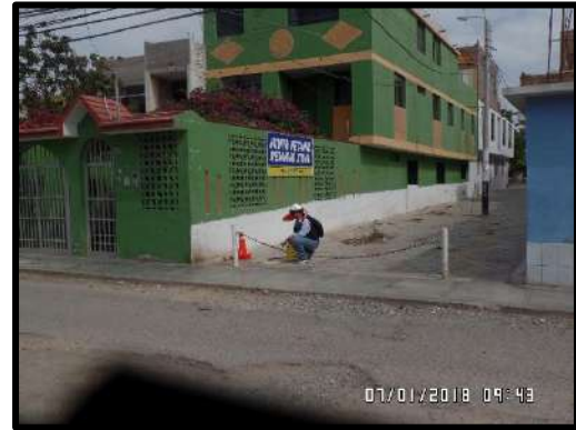
Figura 68. Se puede apreciar otra toma de la realización de mediciones a distancia con wincha en el buzón ubicado entre Av. El Progreso y Pasaje Manuel Mendez.
