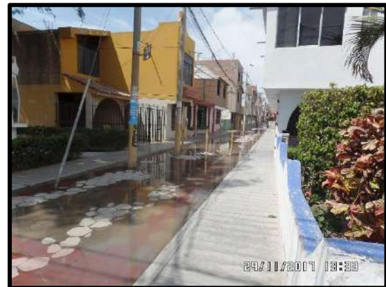
Figura 52. Se puede apreciar una vez más pero en diferente fecha las aguas residuales en las calles, pasajes y avenidas.
