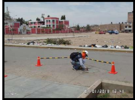
Figura 72. Se puede apreciar otra toma de la realización de mediciones a distancia con wincha en el buzón ubicado en la Calle Refunio Echenique.
