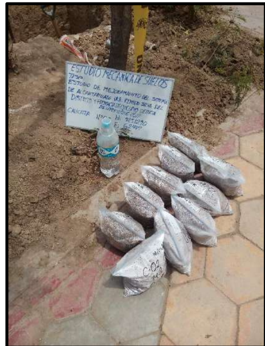
Figura 106. Se puede apreciar en esta foto la extracción de la muestras de la segunda calicata.
