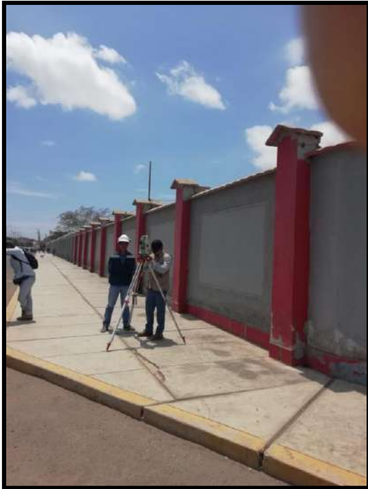
Figura 22. Se realizo otro cambio de estación para el traslado hacia de las coordenadas del punto geodesico, por el Estadio Elias Aguirre.
