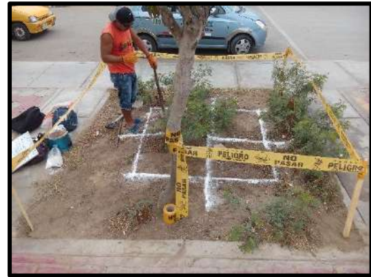
Figura 105. Se puede apreciar en esta foto la señalización de los cuadrantes para la segunda calicata en forma escalonada
