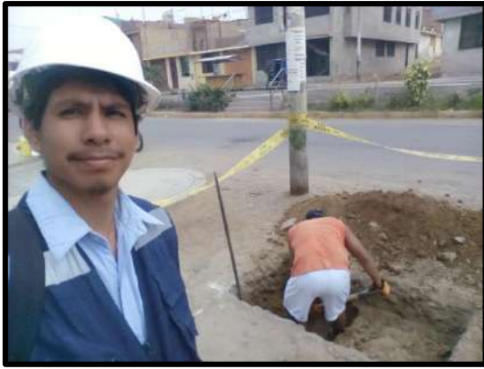
Figura 107. Se puede apreciar en esta foto el comienzo de la tercera calicata y de la misma forma en forma escalonada
