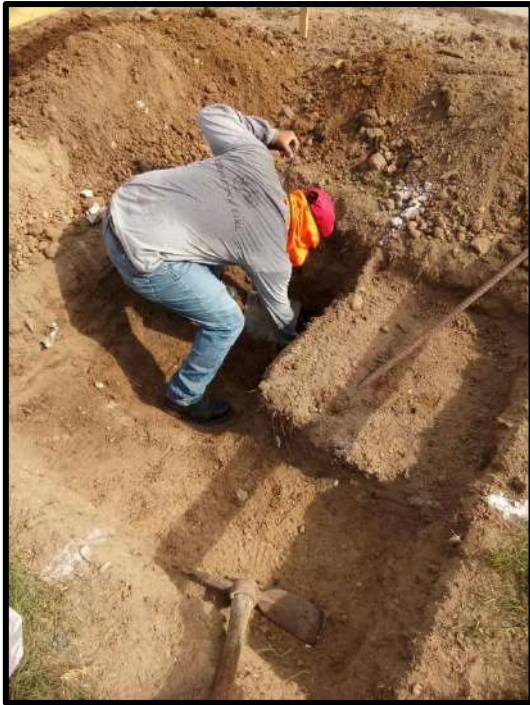
Figura 103. Se puede apreciar en esta foto la forma de la primera calicata en gradas.
