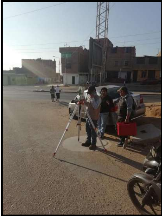
Figura 31. Cambio de estación de la poligonal cerrada PL-06 entre Echenique y Av. Del Progreso.
