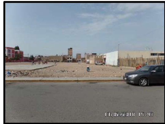
Figura 101. Se puede apreciar en esta toma, el punto con gps para la cuarta calicata ubicada en la Ca. Refunio Echenique y Ca. Tomas Gutierrez.
