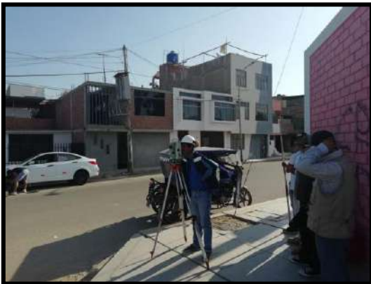
Figura 27. Se realiza la verificación de la toma de lectura para la poligonal cerrada en la estacion PL-02.
