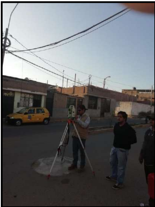
Figura 32. Cambio de estación PL-07 para seguir con el cierre de la poligonal cerrada.
