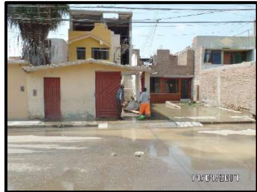
Figura 48. Se puede apreciar que las viviendas fueron también colapsadas por aguas residuales, impidiendo la salida de sus viviendas.
