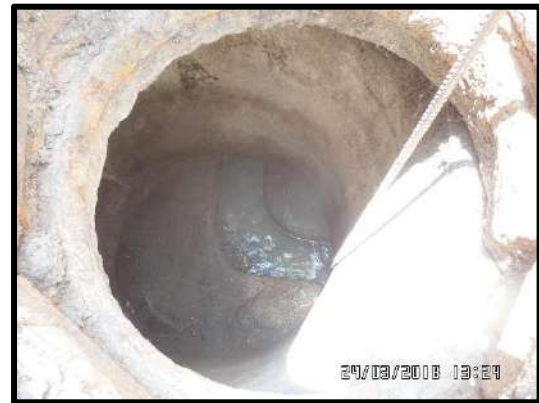
Figura 92. Se puede apreciar en esta toam el cambio de flujo y que atraviesa por debajo las tuberías en las vivienda.
