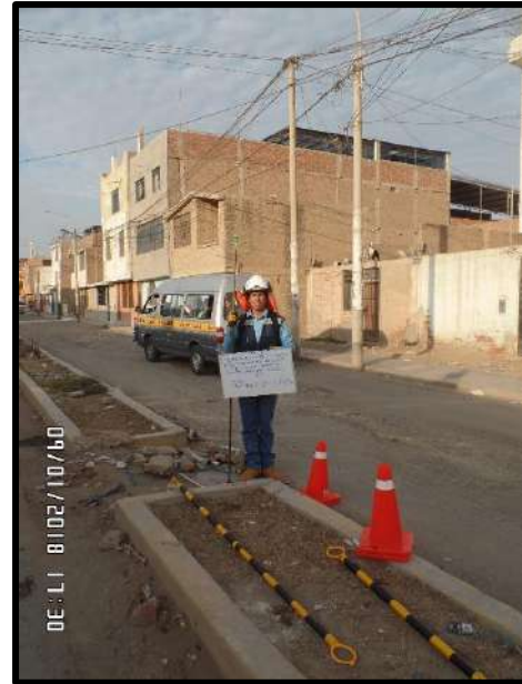
Figura 80. Se puede apreciar otra toma de la realización de mediciones de altura en el buzón ubicado en en la Av. El Progreso
