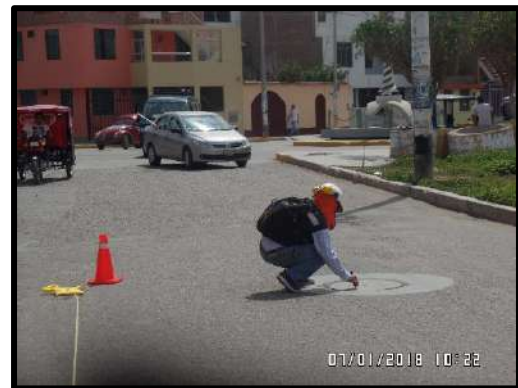
Figura 69. Se puede apreciar otra toma de la realización de mediciones a distancia con wincha en el buzón ubicado en la Av. Belaunde.
