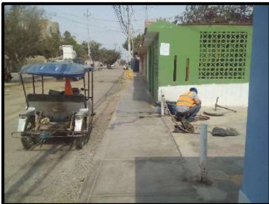
Figura 51. Se puede apreciar, como los personales de Epsel viene hacer los desatoros de los buzones.
