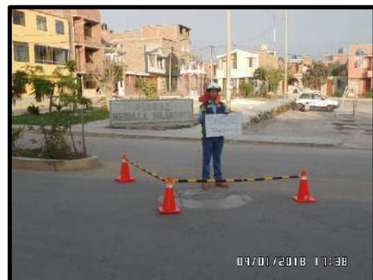
Figura 81. Se puede apreciar otra toma de la realización de mediciones de altura en el buzón ubicado en en la Av. El Progreso
