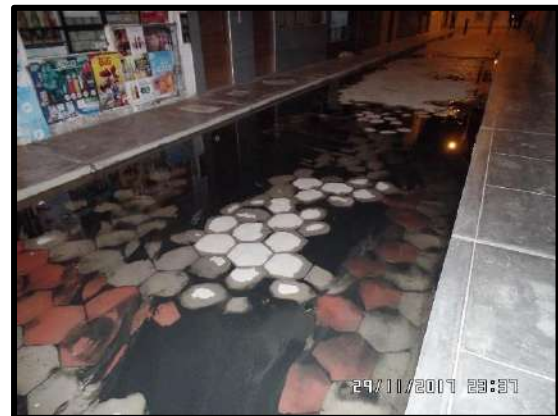
Figura 57. Se puede apreciar otra toma que las aguas residuales impida salir a los propietarios de dichos lotes en el pasaje Domingo Elias y deje todo ese sedimento negro.
