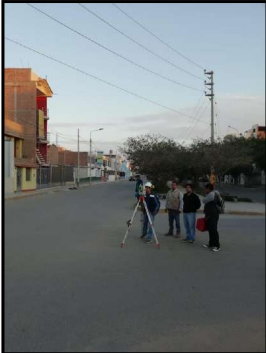
Figura 36. Cambio de estación PL-12 para seguir con el cierre de la poligonal cerrada, entre la Av. Belaunde y Av. Sarumilla.
