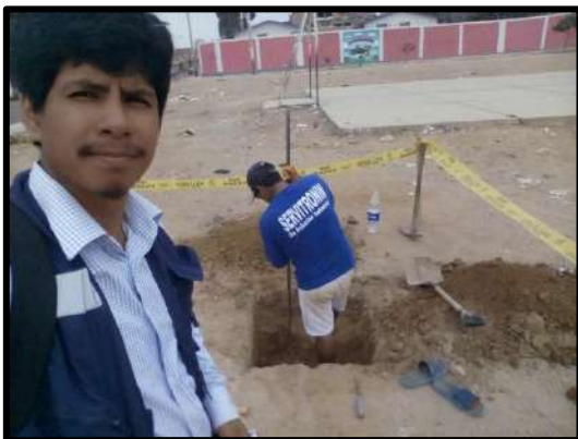
Figura 108. Se puede apreciar en esta foto el comienzo de la calicata numero cuatro para la extraccion de muestra respectiva.
