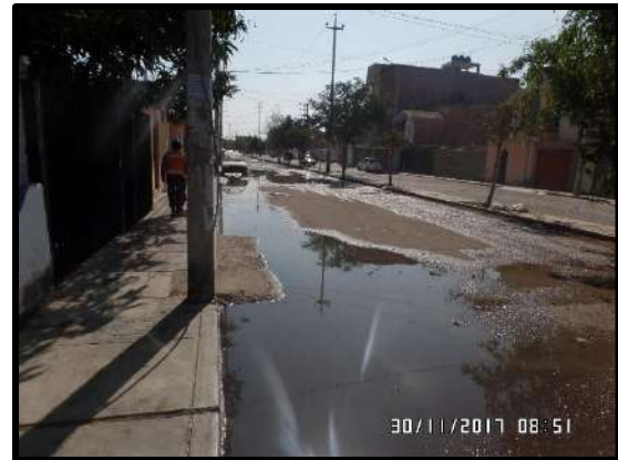
Figura 61. Se puede apreciar otra toma que las aguas residuales en la gran parte de la Av. Belaunde.
