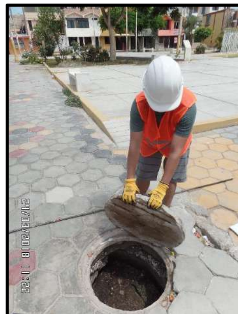
Figura 89. Se puede apreciar otra toma de la realización de mediciones de altura en el buzón ubicado en Ca. Antonio Arenas y Psj. Miguel Iglesias.
