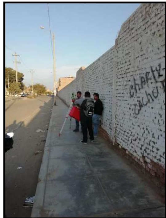
Figura 34. Cambio de estación PL-09 para seguir con el cierre de la poligonal cerrada.
