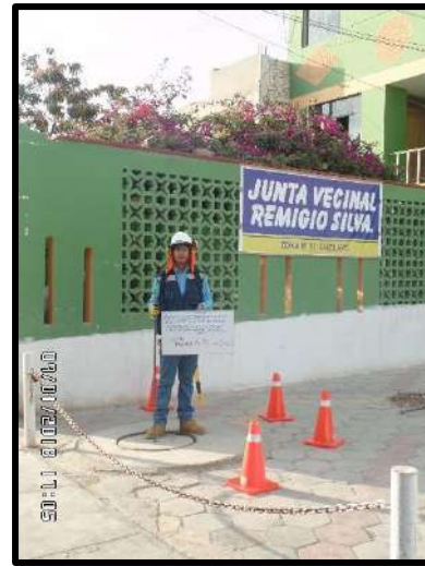
Figura 76. Se puede apreciar otra toma de la realización de mediciones de altura en el buzón ubicado en el pasaje Manuel Mendez
