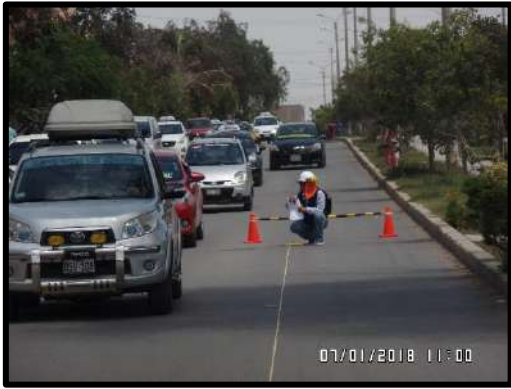
Figura 70. Se puede apreciar otra toma de la realización de mediciones a distancia con wincha en el buzón ubicado en la Av. Zarumilla.
