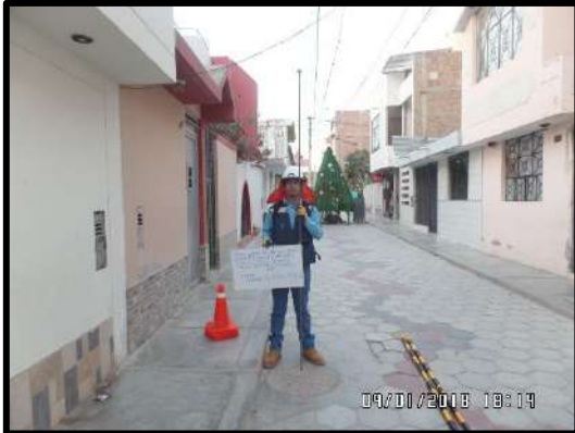
Figura 86. Se puede apreciar otra toma de la realización de mediciones de altura en el buzón ubicado en el Psj Manuel Galvez.
