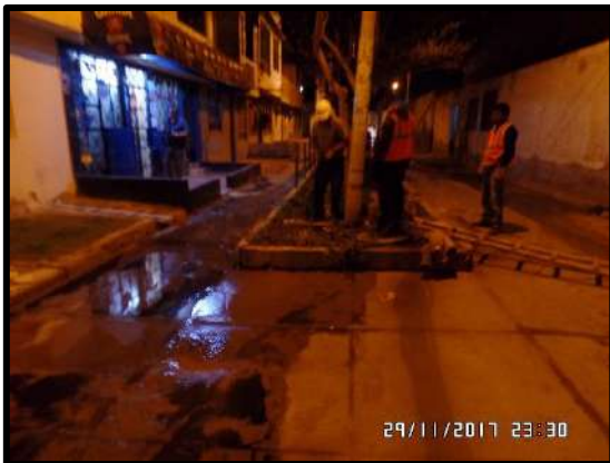
Figura 55. Se puede apreciar en dicha vista, la limpieza del buzón en calle Diaz Calderon por parte del personal de Epsel a dichas altas horas de la noche.
