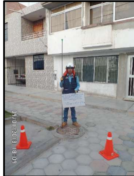
Figura 84. Se puede apreciar otra toma de la realización de mediciones de altura en el buzón ubicado en Ca. La Sierra y Psj. Manuel Galvez.
