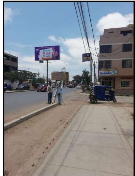
Figura 21. Se realizo la primera Estacion para el traslado de las coordenadas del punto geodesico hacia el BM de la Urb. Remgio Silva.
