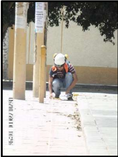
Figura 62. Se puede apreciar otra toma de la realización de mediciones a distancia con wincha en el buzón ubicado entre Av. Belunde y Calle. Ramón Herrera.
