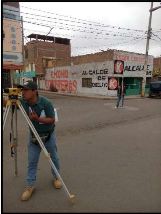
Figura 39. Se observa al topografo tomadon la lectura del BM y a sus espaldas para tomar la lectura para el respectivo buzón.
