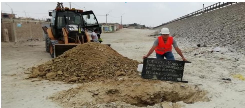
Ilustración 22: Excavación de calicatas
