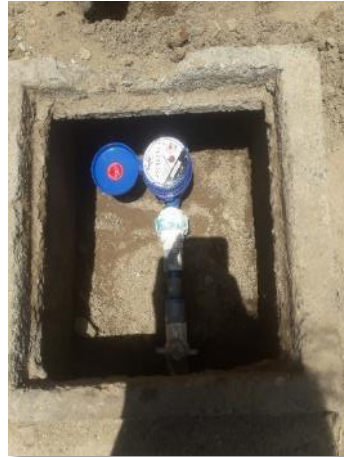
Figura N° 4: Instalación de Medidores
