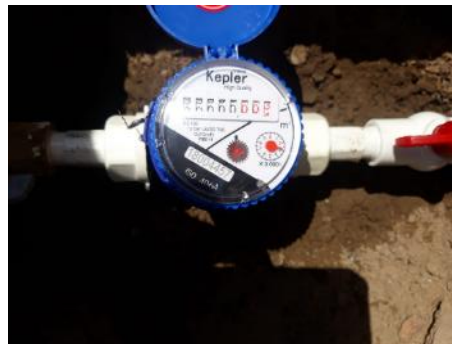
Figura N° 5: Instalación de Medidores
