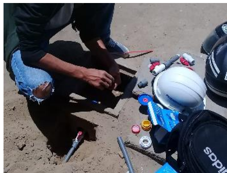
Figura N° 3: Instalación de Medidores
