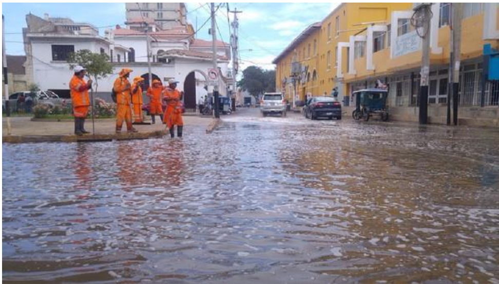
Figura 2. Colapso De Las Calles De Piura Debido A La Inexistencia De Un Drenaje Pluvial Después De Un Desastre Natural Fuente: (RPP, 2017)
