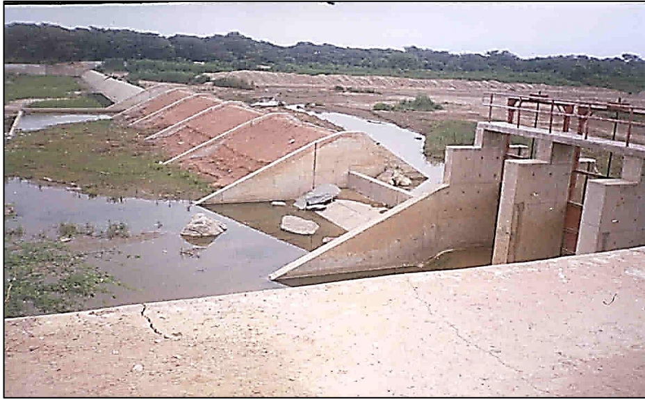
Figura 19. Vista panorámica antes del inicio de los trabajos de reforzamiento Fuente: DEPOLTI, (2003)
