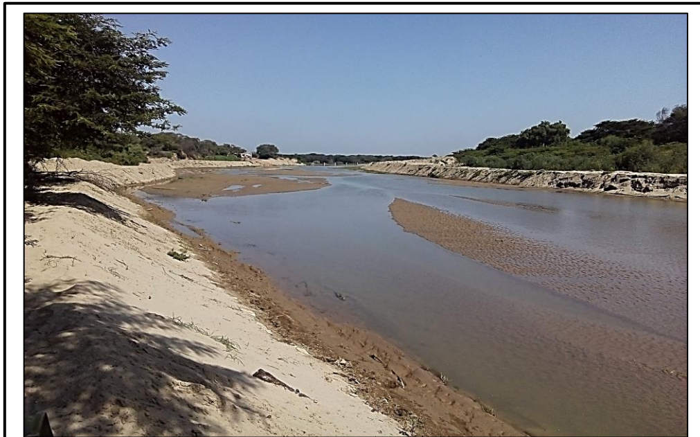
Figura 9. Sección del cauce - Aguas arriba de la Bocatoma Huaca de la Cruz
