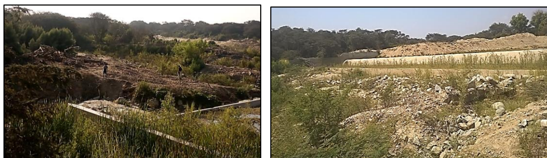
Figura 8. Colmatación de rocas y vegetación - Aguas abajo de la Bocatoma Huaca de la Cruz Fuente: Elaboración Propia
