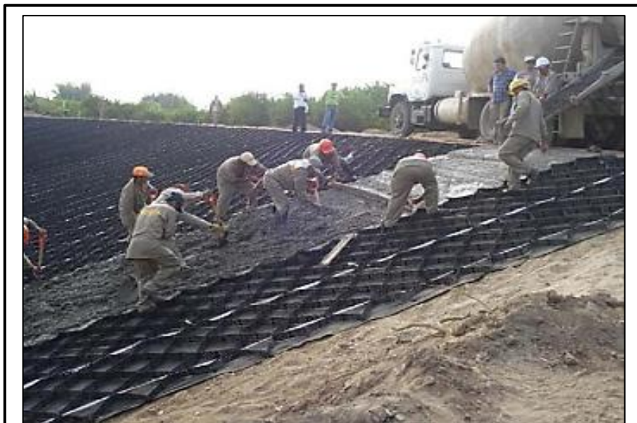
Figura 15. Relleno de Concreto en Goceldas. Fuente: TDM (como se citó en Aguilar, 2016).
