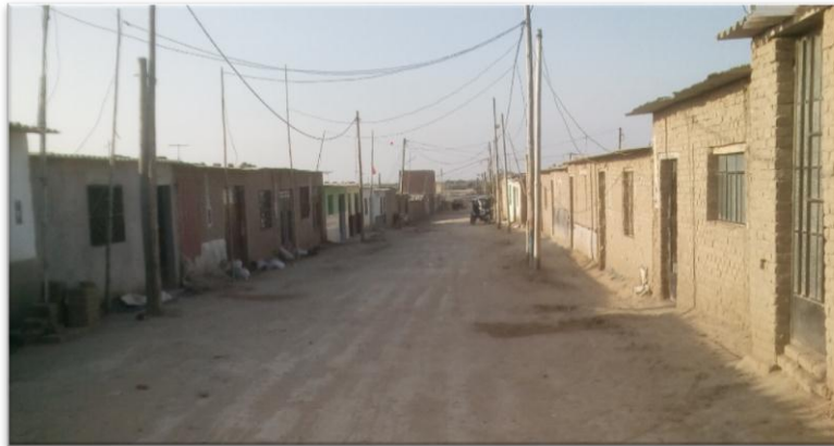
Figura 3. De las 23 piletas existentes 10 cuentan con estructura que las proteja, las demás no presentan ninguna protección para los habitantes ya que se puede apreciar que podría suceder un accidente al caer en el hoyo algún transeúnte.
