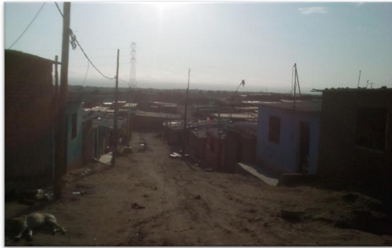
Figura 5. La superficie del terreno tiene pendientes pronunciadas, que hay que tomar muy en cuenta al momento de diseño de alcantarillado. Además se observa los postes de madera con cableado eléctrico, que son potencialmente riesgosos. Fuente: (Propia, 2018).
