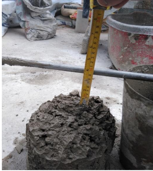
Figura 19: Evaluación del asentamiento de la mezcla de concreto.
