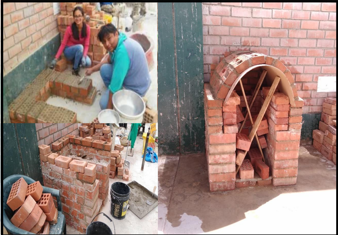
CONSTRUCCIÓN DEL HORNO ARTESANAL
