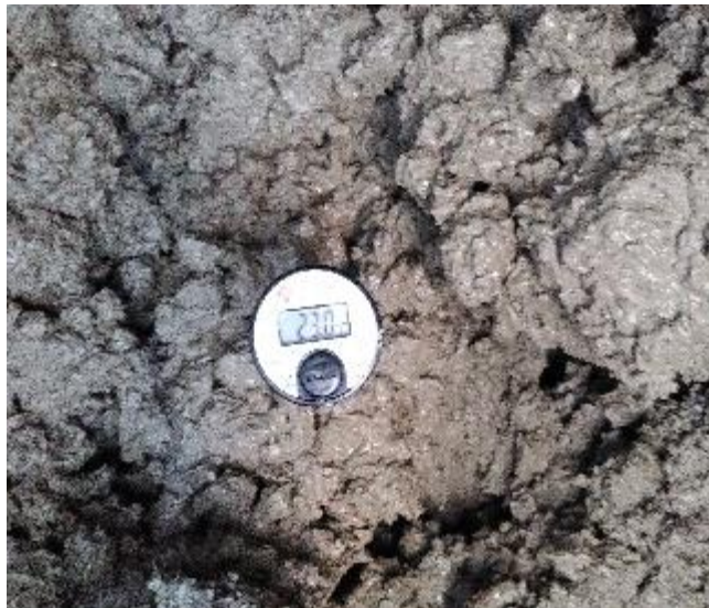
Figura 18: Evaluación de la temperatura de la mezcla de concreto.
