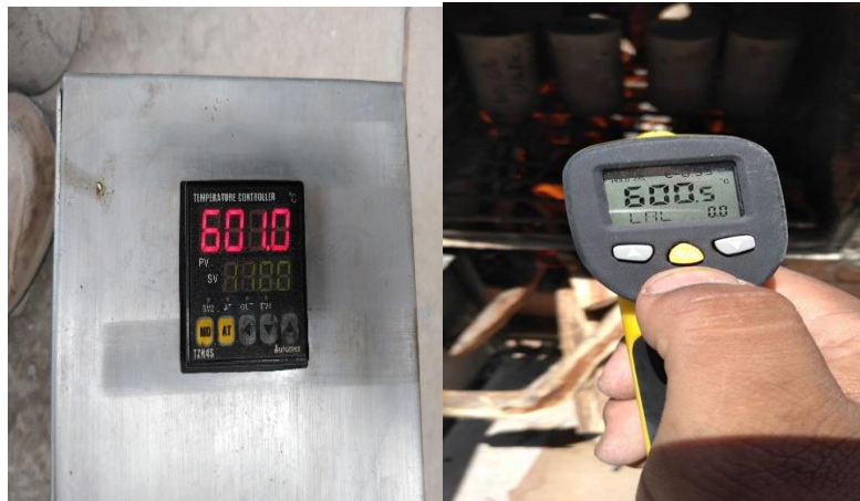
Figura 25: Equipos de medición de temperatura.
