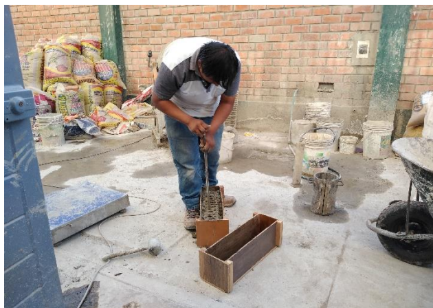
Figura 23: Elaboración de vigas de concreto armado
