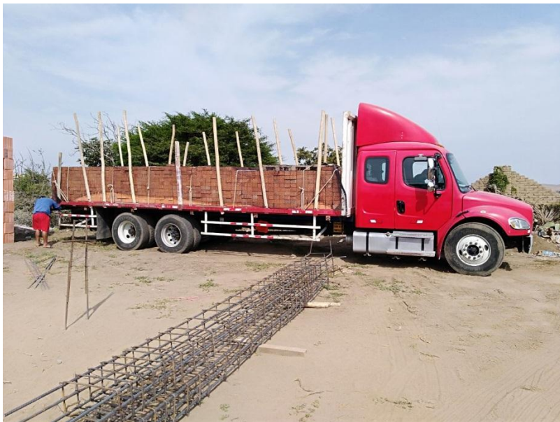
Figura 19. Llegada de Materiales de Ladrillo-Reque
