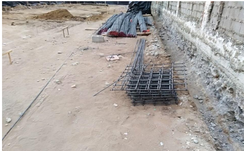
Figura 21. Fierro Corrugado Tirado en plena Obra-Reque
