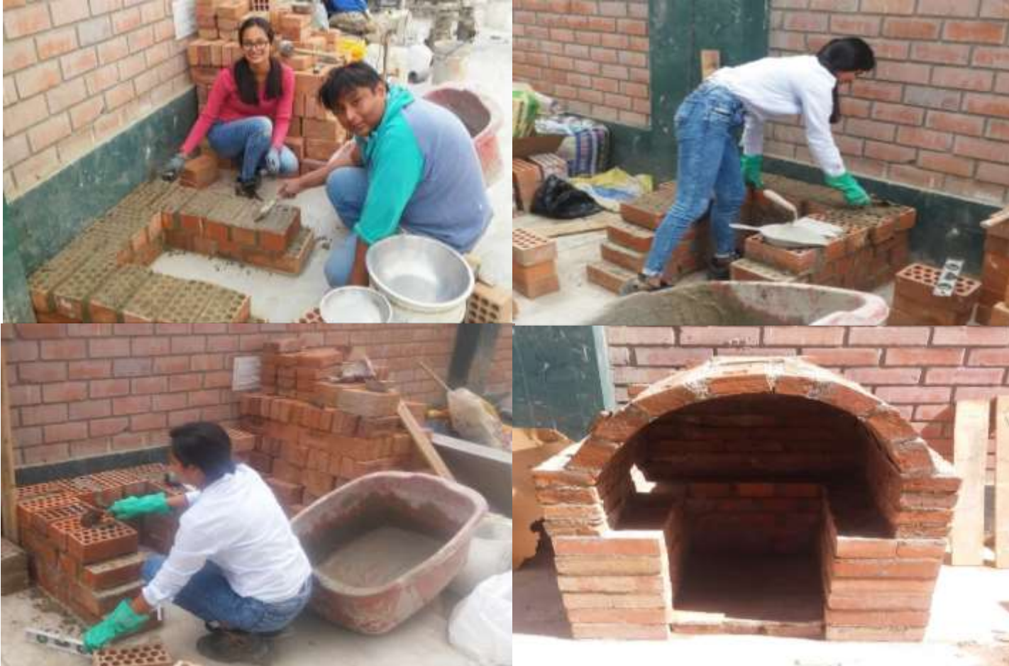
Proceso de construcción de horno artesanal, con ladrillo King Kong 18 huecos Tipo IV y artesanal.
