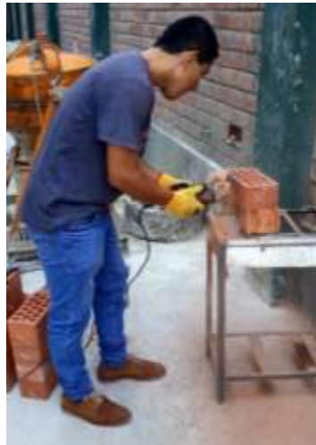
Figura 41. Cortando los ladrillos por la mitad para ser ensayados.
