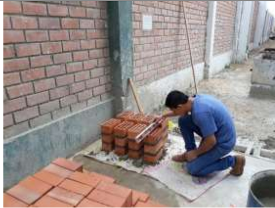
Figura 59. Verificación de nivelación de pilas para el ensayo de adherencia.
