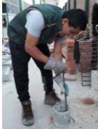
Figura 31. Apisonamiento del agregado fino utilizando la varilla.
