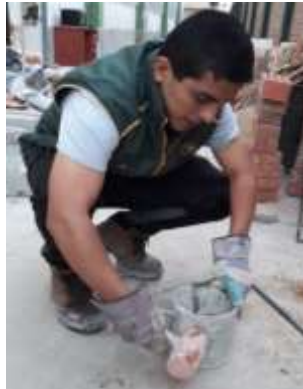
Figura 32. Compactando la capa del agregado fino usando la comba de goma.
