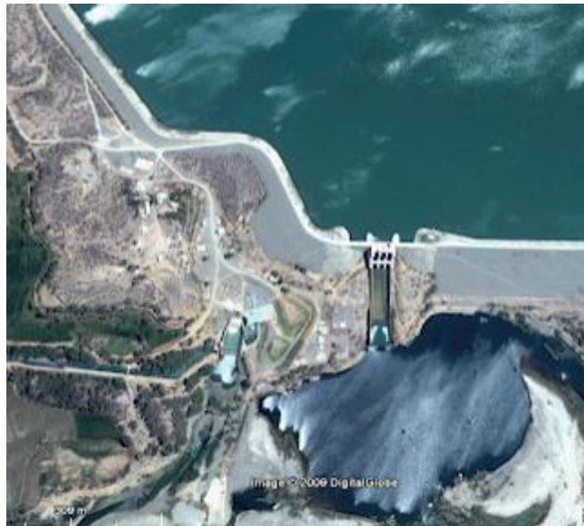
Figura 3. Socavación de la presa Poechos.
