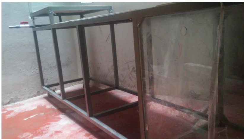
Figura 37. Apoyos verticales de estructura metálica.
