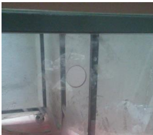
Figura 43. Perforación circular en tanque de almacenamiento.
