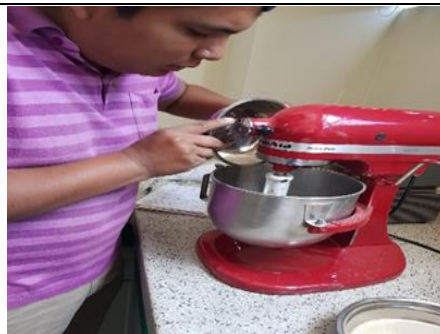
Figura 25: Preparación de la mezcla de mortero.
