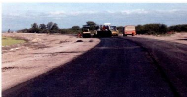
Figura 24: condición de la estructura del pavimento dañado superficialmente
