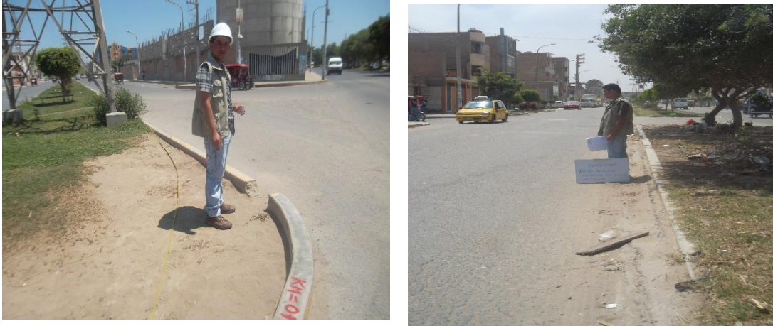
Figura 55 : Av.los treboles. De dos carriles con un separador central
