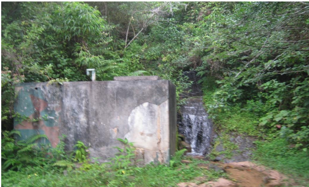
Figura 14: Vista del reservorio utilizado por la localidad de Cangall – Huillín el cual ya cumplió su vida útil.
