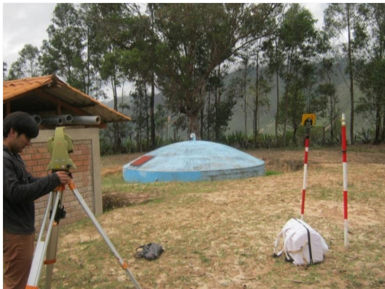
Figura N° 10. Vista del reservorio de la localidad de Magdalena, el cual no presenta una ubicación adecuada debido a que la pendiente mínima con respecto a la estructura de tratamiento (flocurador y casa de mezclas).
