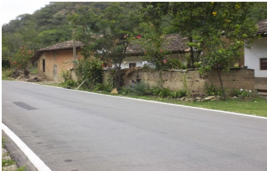
Figura 12. Vista de la localidad de Cangall a lo largo de la vía asfaltada.
