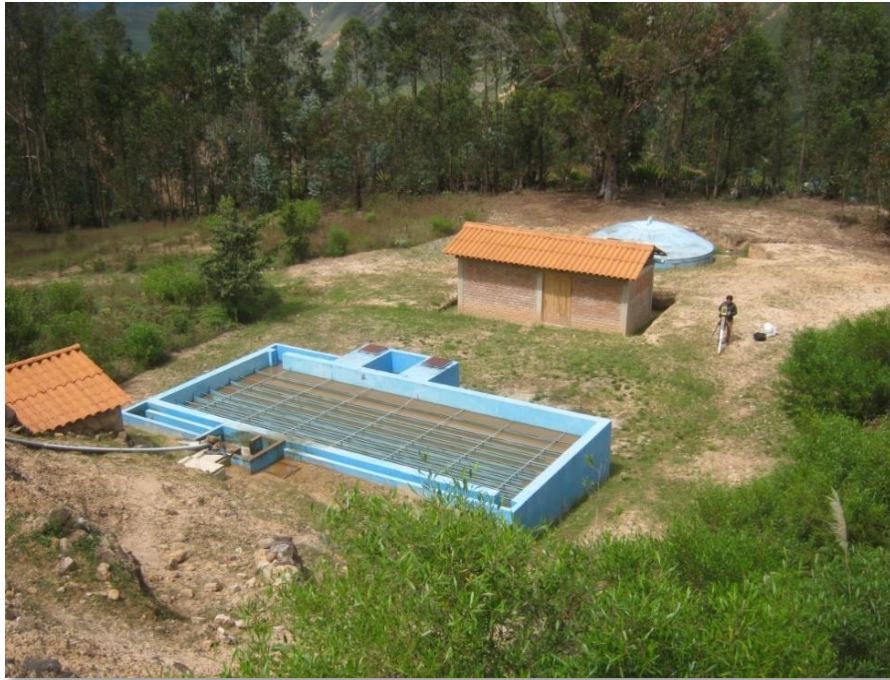
Figura 9. Vista del lugar en donde se ubican las estructuras de floculación, casa de mezcla (cloración) y reservorio actual de la localidad de Magdalena.
