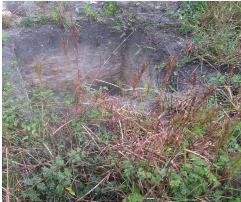
Figura 48. Calicata (C-04) Ubicada en donde se proyectará el reservorio.
