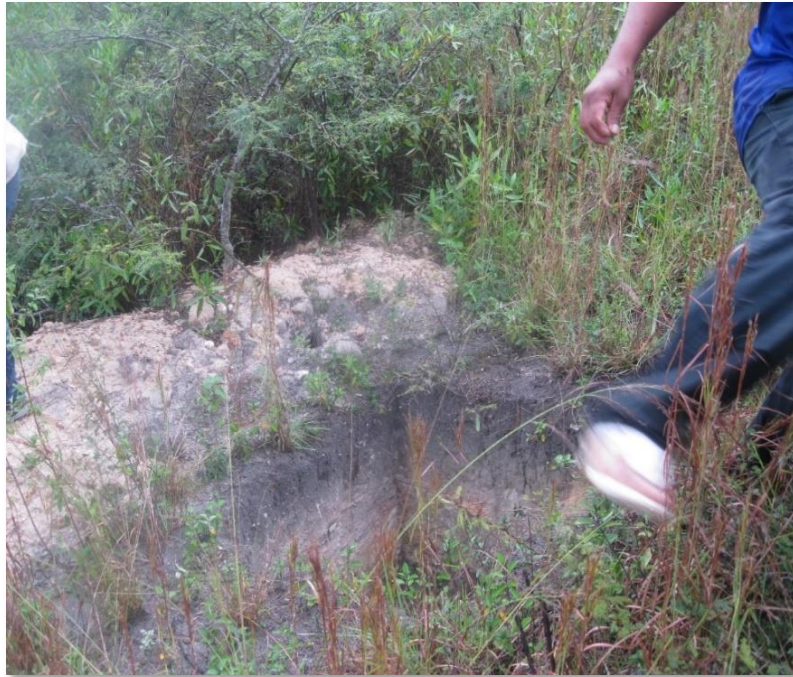
Figura 50: Calicata (C-02) Ubicación en donde se proyectará el Sedimentador
