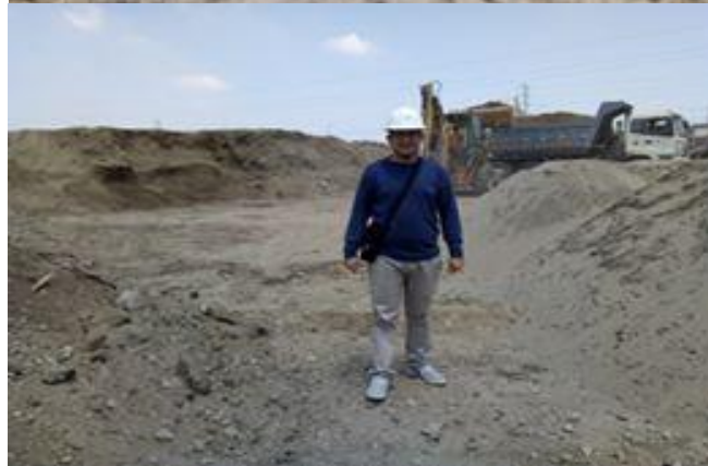
Figura 38. Extracción del material granular, para la realización del CBR para la subbase.
