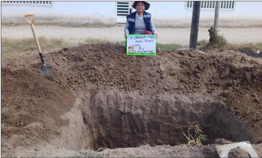
**Figura 63:** Excavaciones de calicatas
