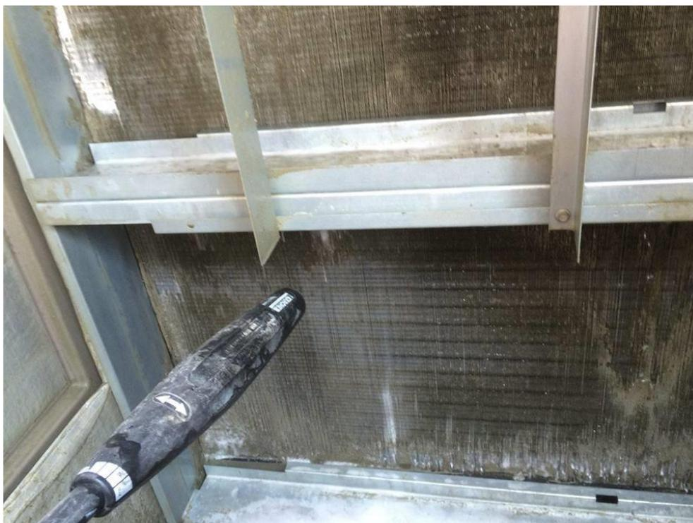
**Figura 12:** Limpieza con antifoam al evaporador
