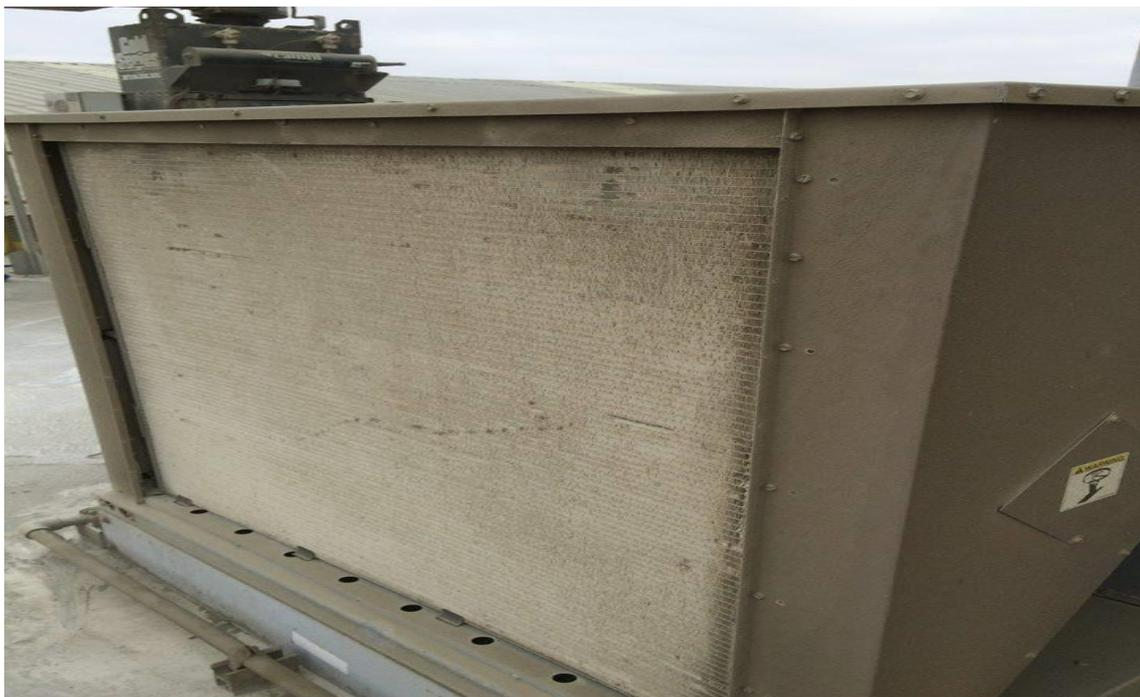
*Figura 8:* Condensador saturado de polvo, antes del mantenimiento del servicio
