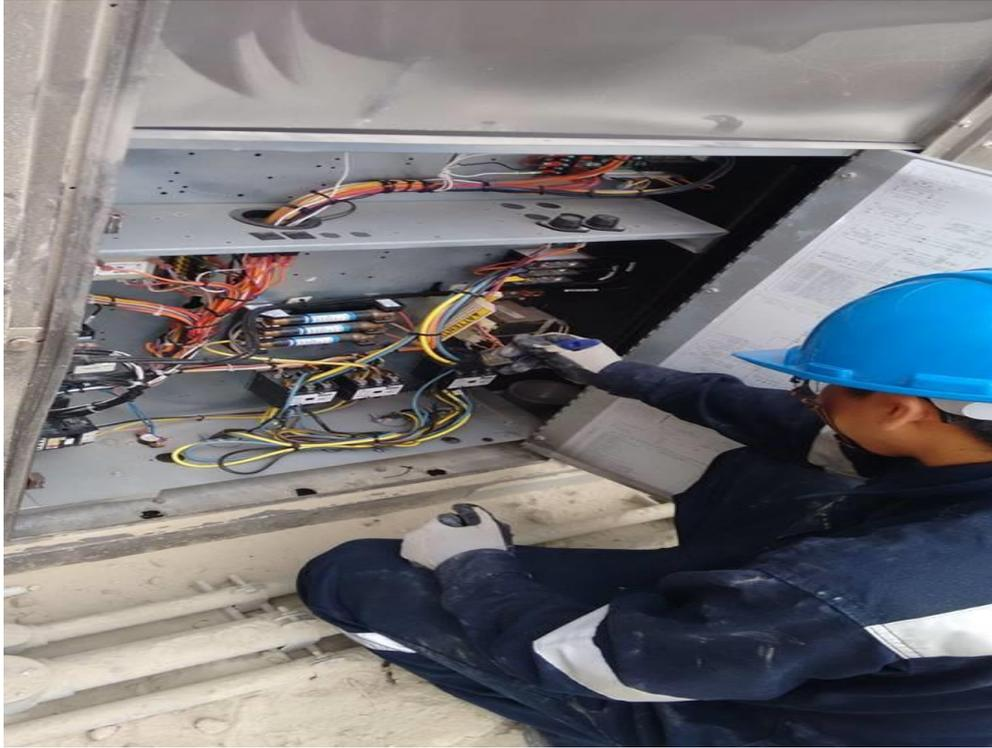
**Figura 13:** Limpieza del tablero eléctrico del aire acondicionado
