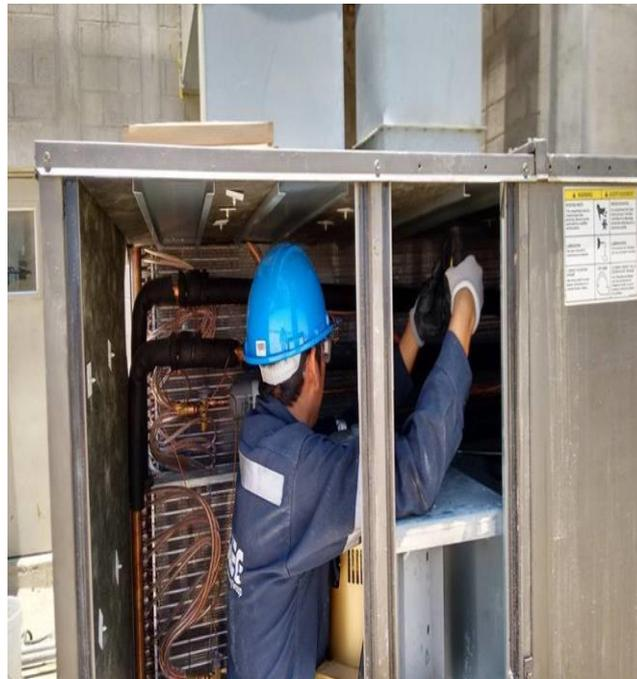
**Figura 10:** Limpieza del evaporador para que pueda enfriar el área requerida
