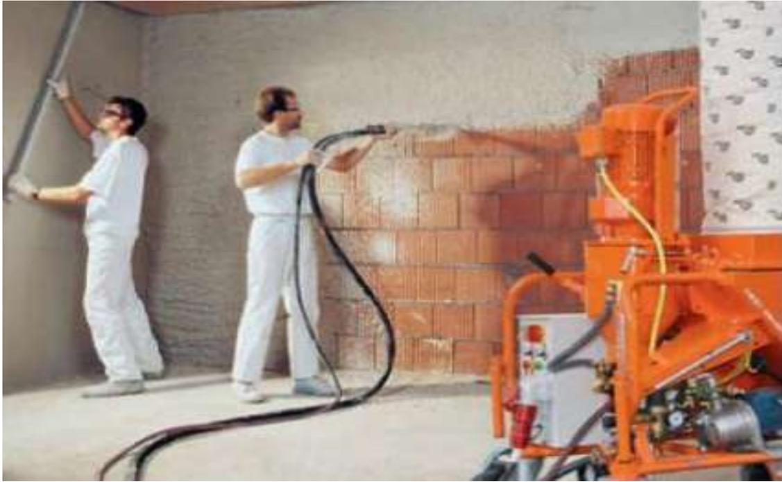
**Figura 21.** Maquina proyectadora de concreto-shotcrete
