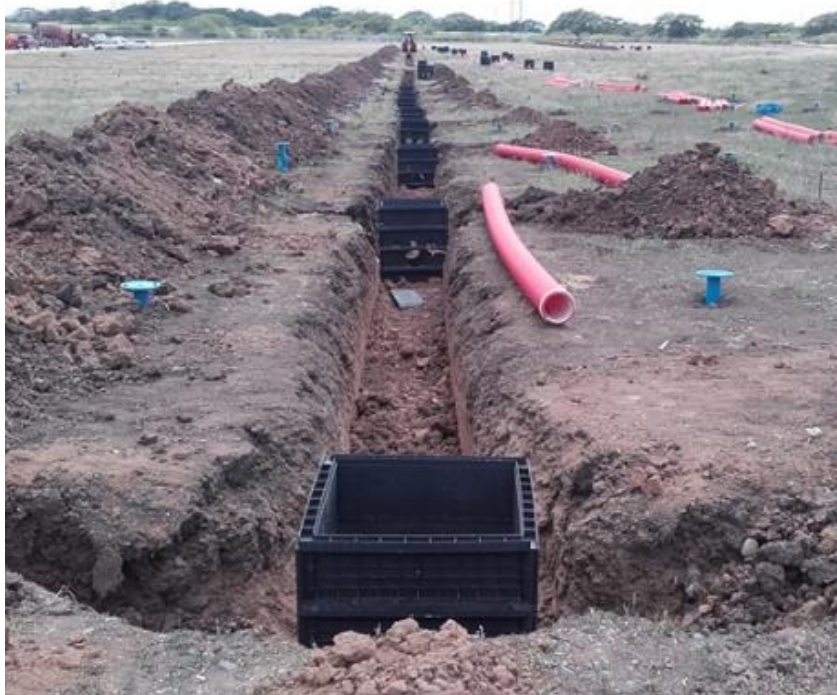
Figura 6: Red de media tensión tendido en una zanja de una Central Solar tipo
