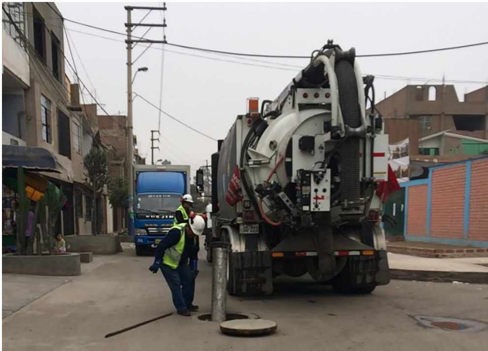
Levantamiento de Información, limpieza de redes de alcantarillado con Hidrojet.
