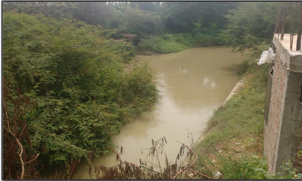
Figura 23: Vista panorámica de canal que suministra agua a caseta de bombeo. Fuente: Canal Miguel Checa – Distrito Marcavelica – Provincia Sullana
