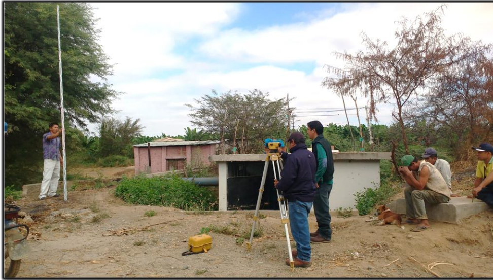
Figura 25: Trabajos de topografía en zona de Caseta de Bombeo Fuente: Caseta de Bombeo de Cooperativa Pequeños Propietarios de Banano Orgánico S.A.
