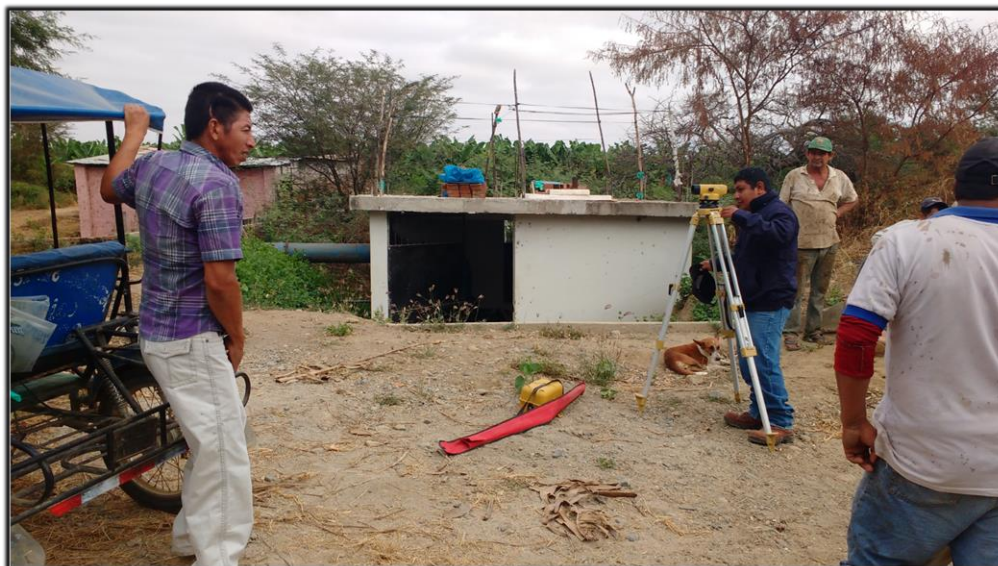
Figura 28: Trabajos de toma de niveles en zona de Caseta de Bombeo Fuente: Caseta de Bombeo de Cooperativa Pequeños Propietarios de Banano Orgánico S.A.
