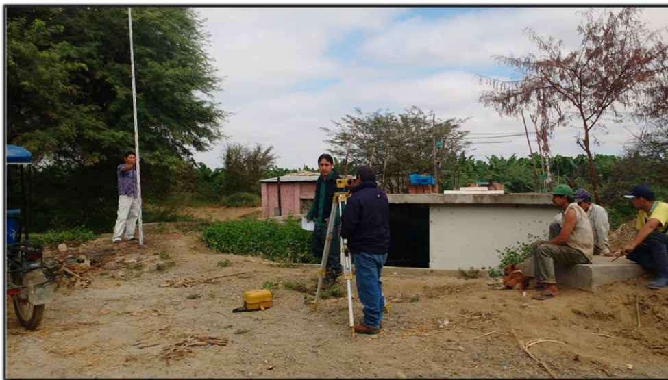
Figura 27: Trabajos de topografía en zona de Caseta de Bombeo Fuente: Caseta de Bombeo de Cooperativa Pequeños Propietarios de Banano Orgánico S.A.
