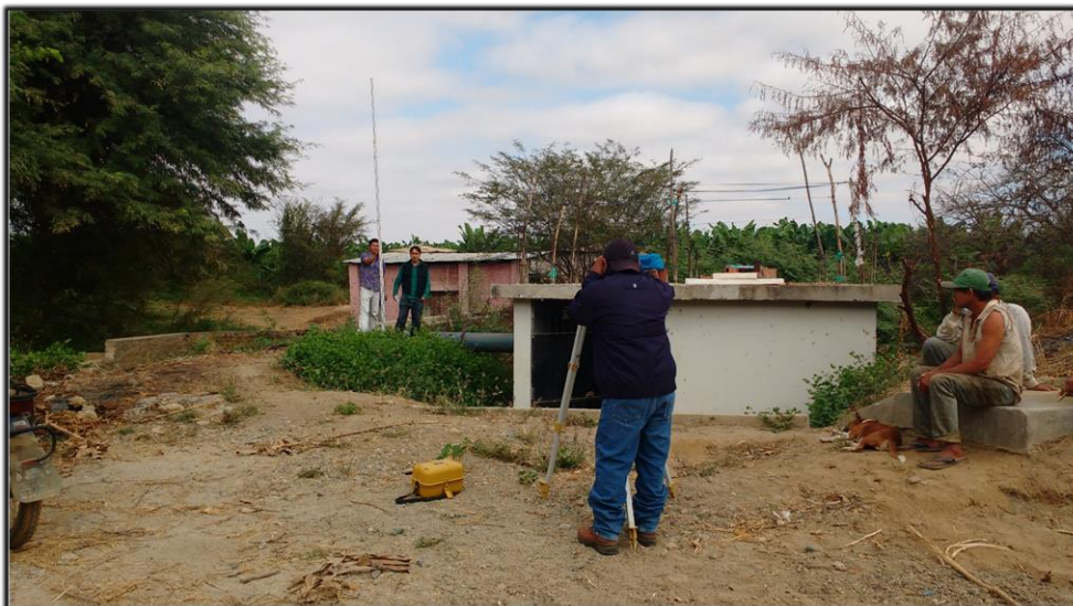
Figura 26: Trabajos de toma de niveles en zona de Caseta de Bombeo Fuente: Caseta de Bombeo de Cooperativa Pequeños Propietarios de Banano Orgánico S.A.
