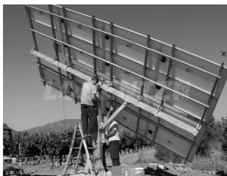
Figura 2.47: Instalación de Seguidor Solar.
