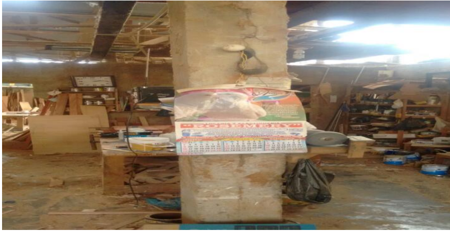
Figura 62. En la figura se observa el almacén desde una perspectiva más amplia.
