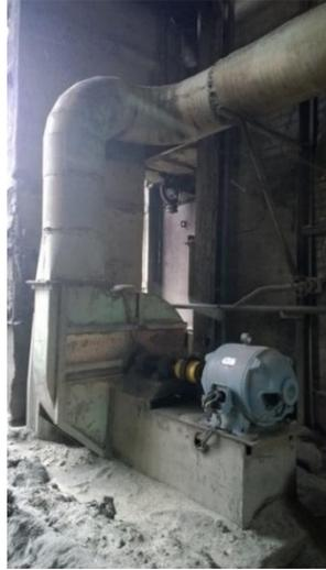
Motor nuevo de 40 hp para inyección de aire secundario
