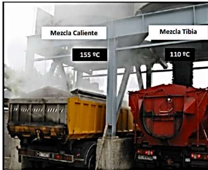
Figura 2: Prueba de comparación en la descarga de mezcla asfáltica a la izquierda una MAC y a la derecha una MAT.
