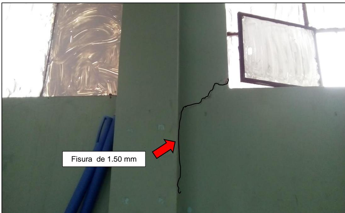
**Figura 4:** *Fisura en vano de ventana por la falta de confinamiento en el tabique y ausencia de junta entre columna y tabique.*
