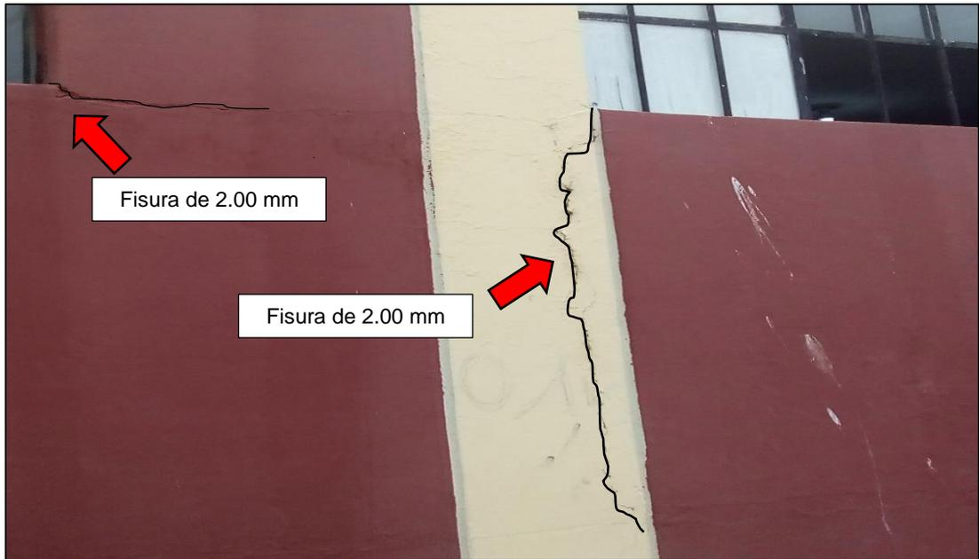
**Figura 5:** Fisura en el revestimiento de muro y columna , debido a la ausencia de junta entre columna y tabique.
